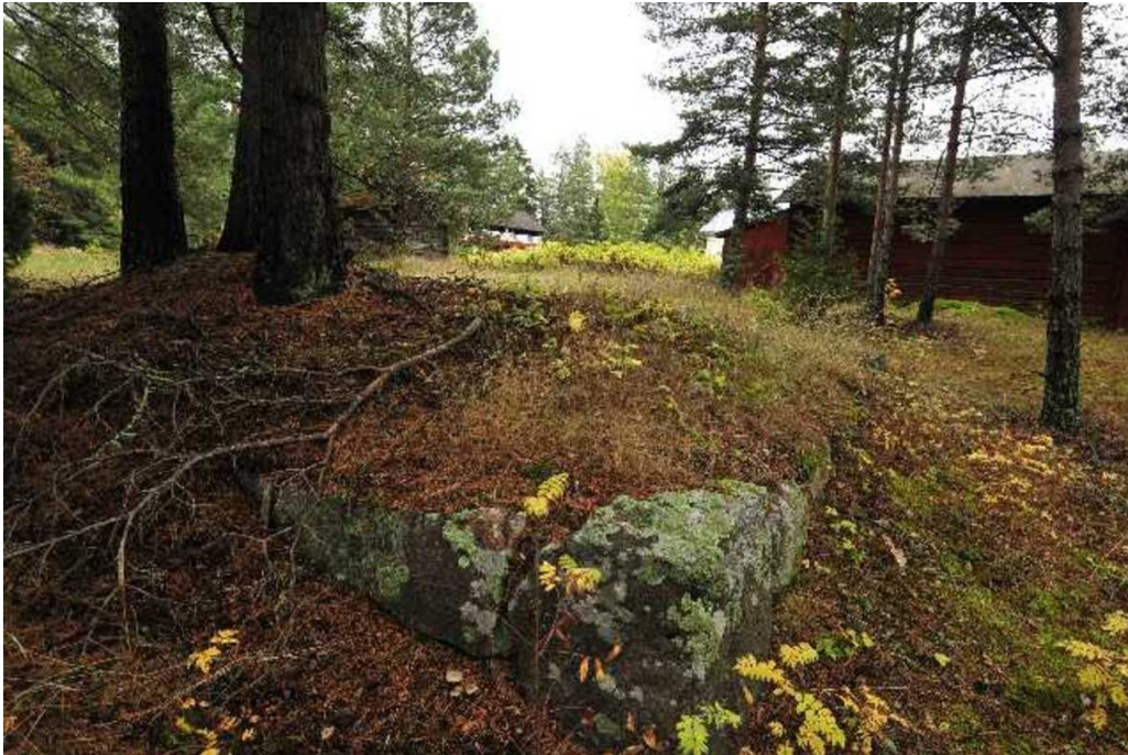
Kuva 4 Keltin vanha kylä, Rakennuksen kivijalka Skyttälän tilan pohjoispuolella © Vesa Laulumaa 2012, Finna-palvelu, Museovirasto
