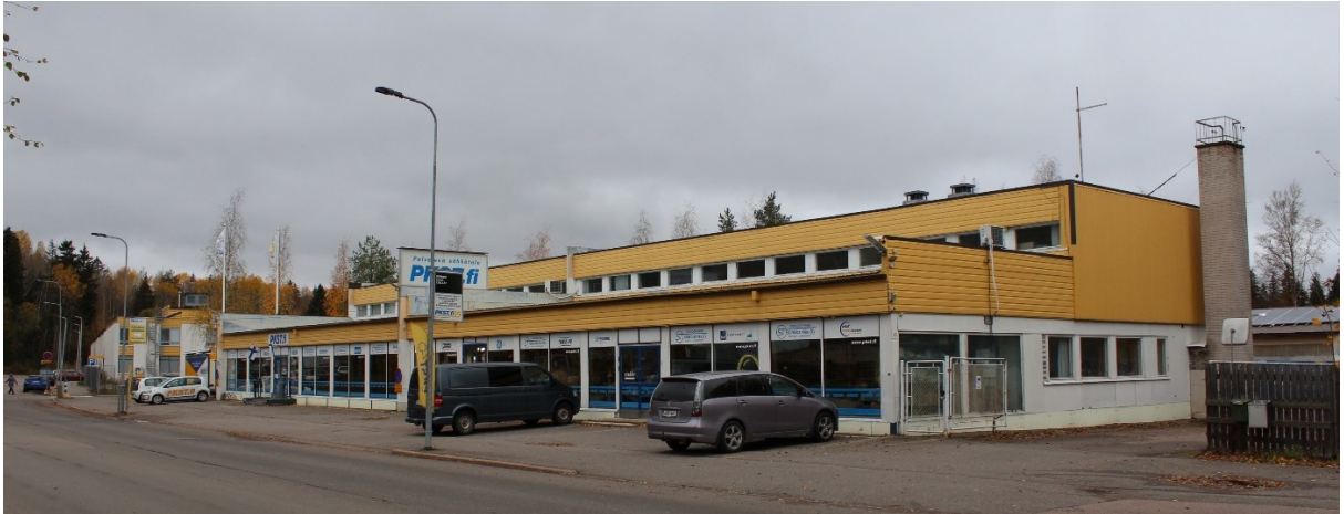
Kuva 9. Savonkatua sen pohjoispuolella rajaavia rakennuksia yhdistää julkisivujen keltainen tehosteväri.
