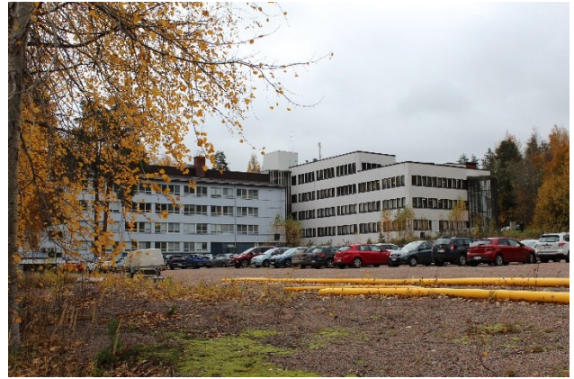
Kuva 7. (oikealla) Näkymä Savonkadun ja Kaikukadun välissä olevia toimistorakennuksia. Etualalla rakentamattoman tontin kohdalla oleva pysäköintialue.
