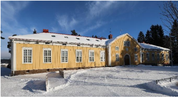
Kuva 3. Pilkan koulu idästä, pääjulkisivun puolelta.
