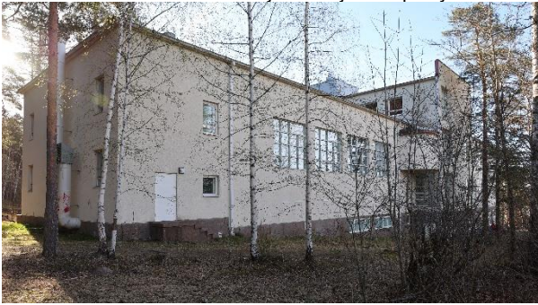
Kuva 6. Keskustan koulun juhlasaliosan länsijulkisivu.
