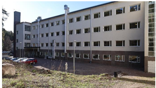
Kuva 4. Keskustan koulun luokkasiiven pohjoisjulkisivu.
