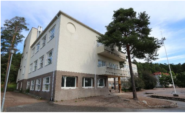
Kuva 5. Keskustan koulun länsijulkisivu ja eteläpääty.
