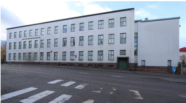
Kuva 7. Oppikujan koulu idästä Kauppalankadulta. Rakennuksen vaihteittainen rakentuminen näkyy julkisivussa.
