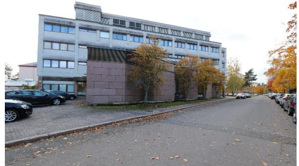
Kuva 11. Energiatalo pohjoisesta, Hovioikeudenkadun puolelta.
