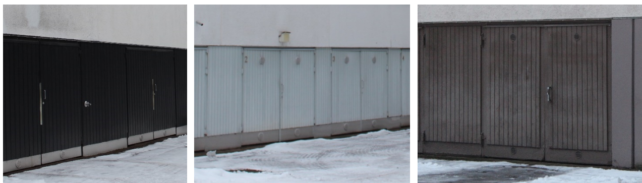
Kuvat 38-40. Autotallien ovet ja niiden välit on paneloitu kellarikerroksen seinien ja sokkelin kanssa saman värisiksi.
