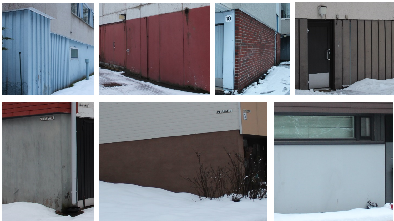
Kuvat 8-14. Sokkelien ja maanpäällisten kellarikerrosten materiaalina on käytetty koko alueella maalattua betonia.
