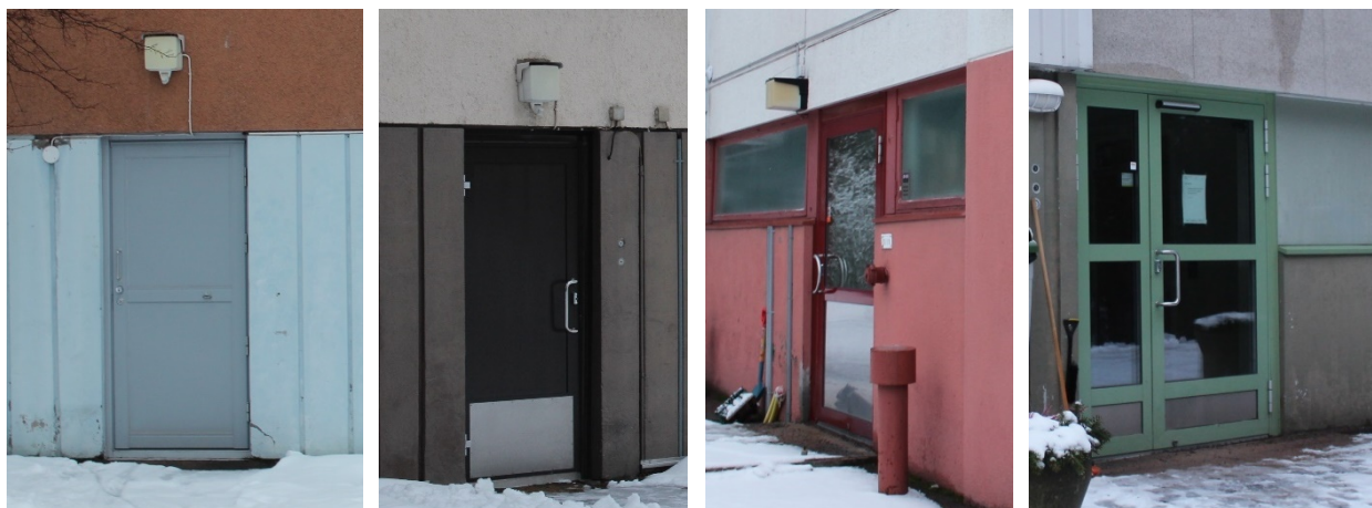
Kuvat 41-44. Kellarien ovet ja niiden välit on paneloitu kellarikerroksen seinien ja sokkelin kanssa saman värisiksi.
