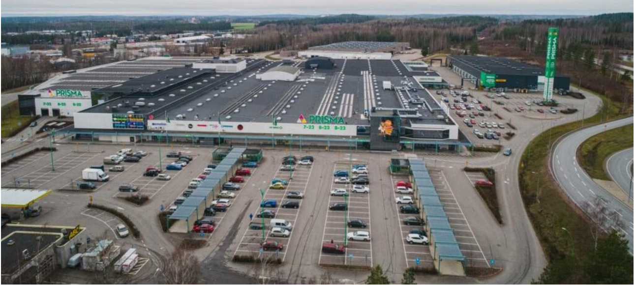
Kuva 2. Syksyllä 2022 otetussa ilmakuvassa Prismakeskus näkyy vuonna 2011 rakennetussa laajuudessaan juuri ennen viimeisintä uudistusprojektia. Tekstilähde ja kuva KSO.
