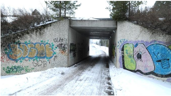
Kuva 28. Kuvassa Tommolankaaren kadun alittava tunneli.
