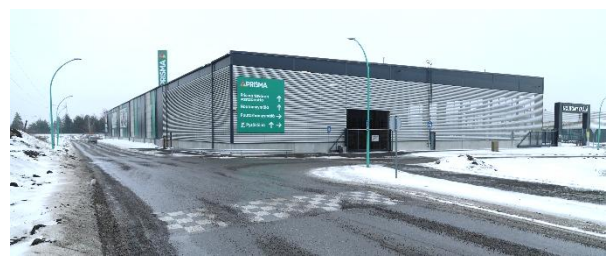
Kuva 25. Rakentajan noutopiha lännestä.
