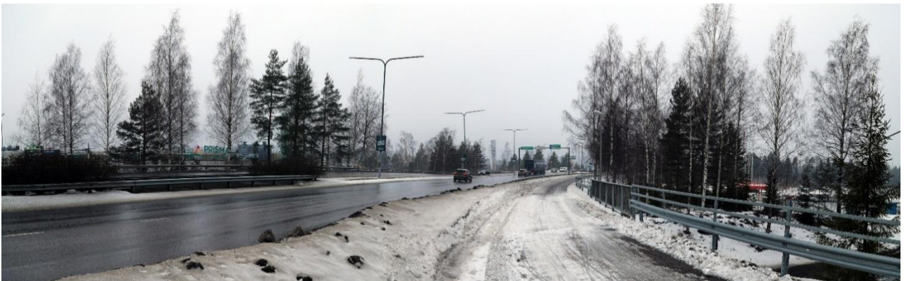
Kuva 4. Näkymä suunnittelualueen itäosasta Kuusaantien katualueelta helmikuussa 2025. Kuvan keskellä Kuusaantie ja sen yhteydessä oleva kevyen liikenteen väylä kulkevat Tommolankadun yli kahta siltää pitkin. Kuvan vasemmassa reunassa näkyy puiden takaa Prisma-keskus ja oikeassa reunassa Tokmannin kiinteistö ja sen edessä oleva paikoitusalue.
