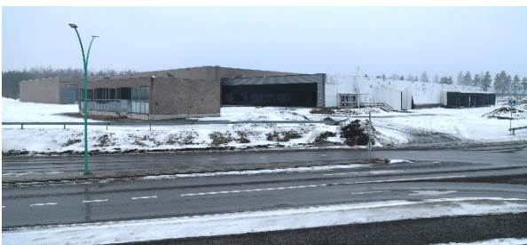
Kuva 23. Korttelin 11001 varastorakennus idästä.
