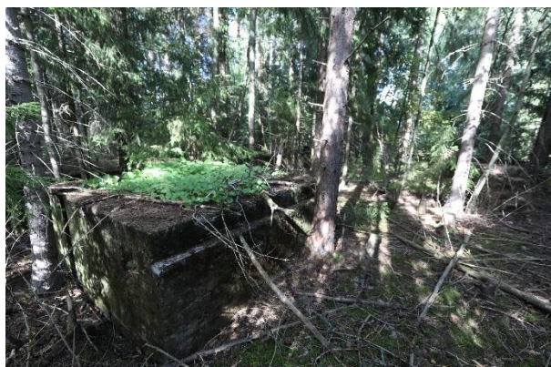
Kuva 14. Työntekijöiden huoltorakennuksen perustus (1950).
