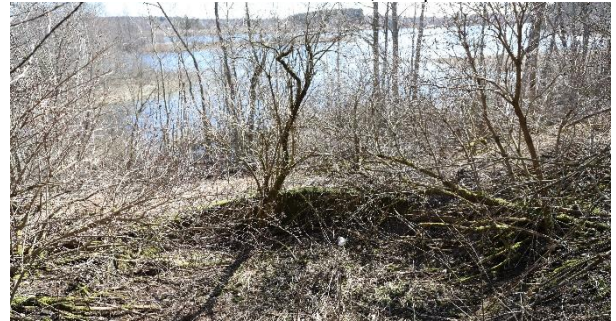
Kuva 16. Kuvassa Kymijoen rannassa olevia betonirakenteita, jotka ovat ilmeisesti AIV-rehusäiliön pohjia.
