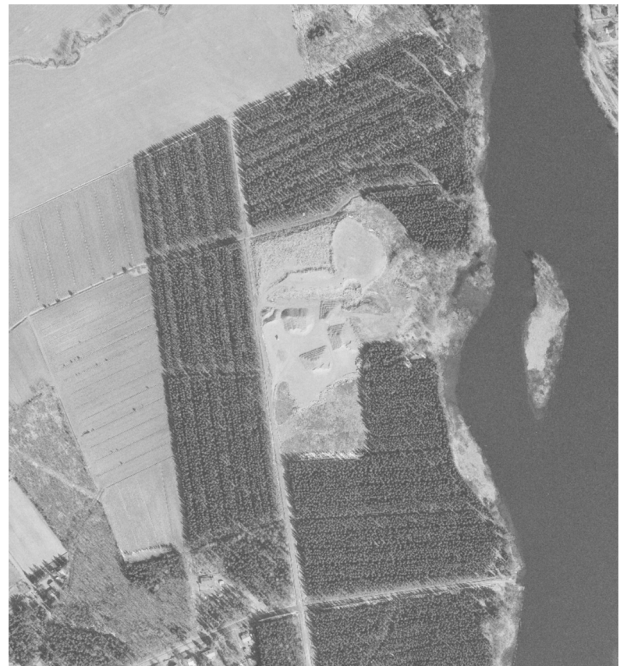
Kuva 7. Ilmakuva alueelta vuodelta 2004, jolloin Myllykosken vesivoimalaitoksen muutostöistä tulleiden maa-ainesten säilyttämiseen tarkoitettu täyttöalue oli laajimmillaan. Alueen keski-osalle on sijoitettu kasoihin erilaisia kiviaineksia.
