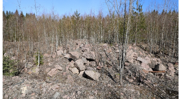
Kuva 17. Osa täytöistä on louhetta ja kiviä, mukana on myös rautaromua ja ilmeisesti suodatinkankaana käytettyä viiraa.
