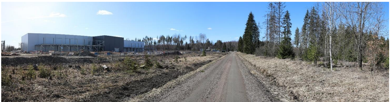
Kuva 3. Näkymä Lossitietä pitkin länteen. Vasemmassa reunassa on rakentumassa atNorthin datakeskuksen 1. vaihe.
