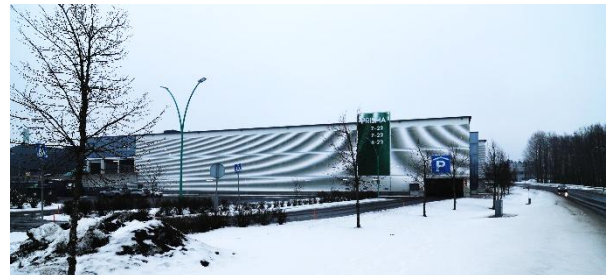
Kuva 23. Prismakeskuksen autopaikoitushalli etelästä.
