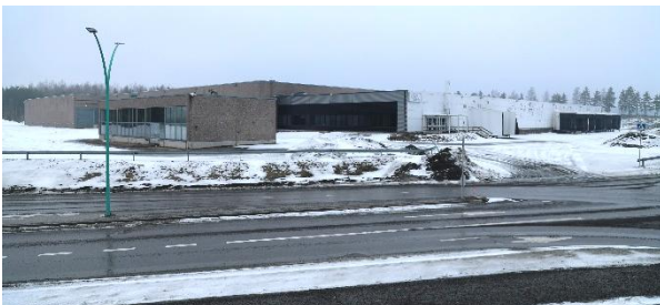
Kuva 20. Korttelin 11001 varastorakennus idästä.
