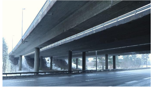
Kuva 28. Valtatie 6:n ylittävät Kuusaantien sillat (3 kpl).
