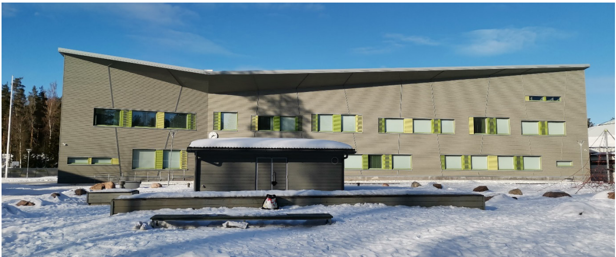
Kuva 4. Mansikkamäen veistoksellisen koulun harmaita julkisivuja elävöittävät vihreät tehoste-elementit ikkunoiden ympärillä.
