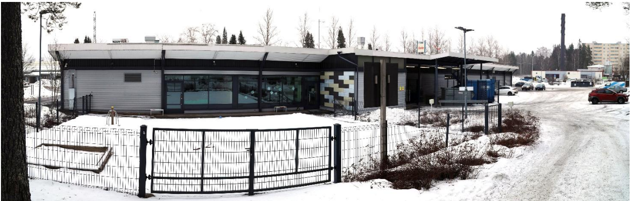
Kuva 12. Näkymä liikerakennuksen huoltopihan puolelta. Piha-alue toimii läpikulkuna Myllypuronraitin ja Sippolankadun välillä.
