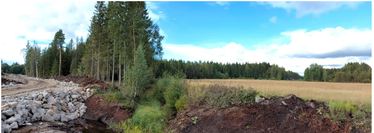
Kuva 3. Näkymä rakenteilla olevalta Kultasuontieltä kohti pohjoista Kullasvaara 3:n asemakaavoitettavalle alueelle.
