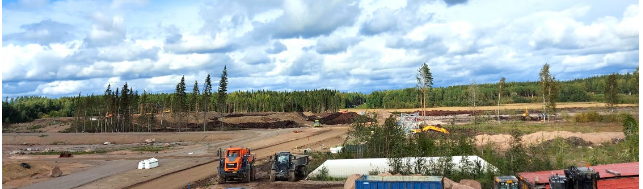
Kuva 2. Näkymä rakenteilla olevan intermodaalialueen pohjoisosasta kohti pohjoista. Kullasvaara 3 asemakaavan suunnittelualueita ovat rakennustyömaan takana näkyvät pellot ja metsät.
