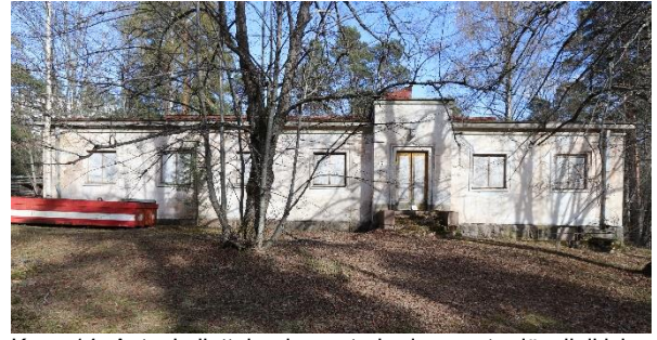
Kuva 14. Autonkuljettajan ja puutarhurin asunto, länsijulkisivu arkkitehti Eino Forsman 1933.
