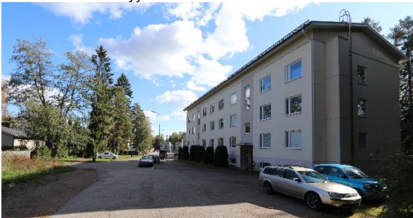
Kuva 13. Näkymä Kallantien ja Viulukujan risteysalueelta itään. Asfaltoitu osa on Kuusaantielle vievää kevyenliikenteen yhteyttä.
