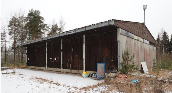
Kuva 4. Konesuojarakennuksen, malli K3/5 on suunnitellut arkkitehti Arvo Sorsa vuonna 1965. Rakennus valmistui v. 1971.
