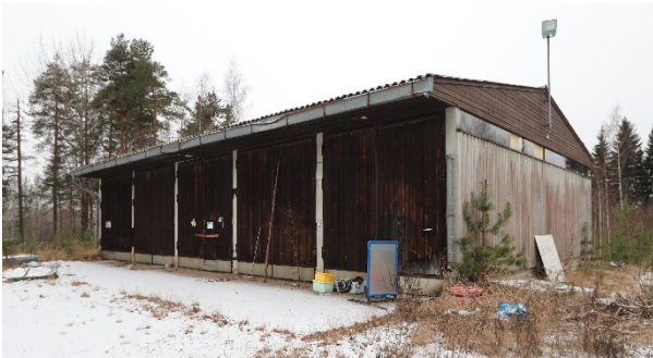
Kuva 4. Konesuojarakennuksen, malli K3/5 on suunnitellut arkkitehti Arvo Sorsa vuonna 1965. Rakennus valmistui v. 1971.
