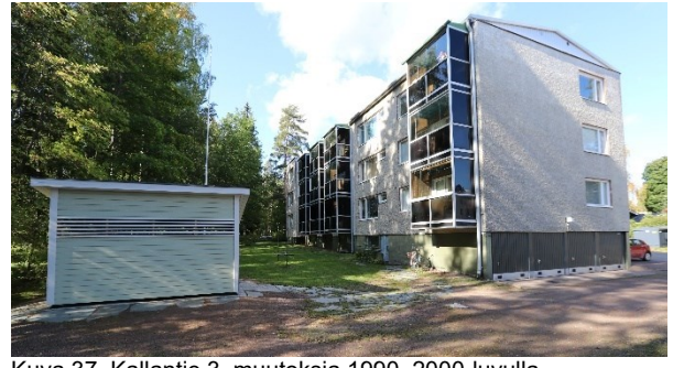
Kuva 37. Kallantie 3, muutoksia 1990–2000-luvulla.
