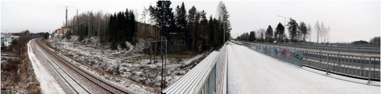
Kuva 3. Näkymä kaavan suunnittelualueelle lännestä Savonradan ylittävältä Kuusaantien kevyen liikenteen sillalta. Taustalla näkyy KSS Energia Oy:n Hinkismäen voimalaitos, jonka suunnitteli arkkitehti Heikki Elomaa vuonna 1987.
