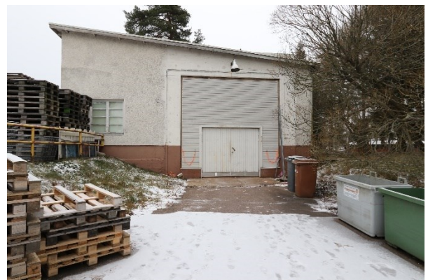
Kuva 18. Huoltamorakennus, lounaisjulkisivu 24.11.2022. Suuri oviaukko on avattu seinään rakennuksen muutostöiden yhteydessä.
