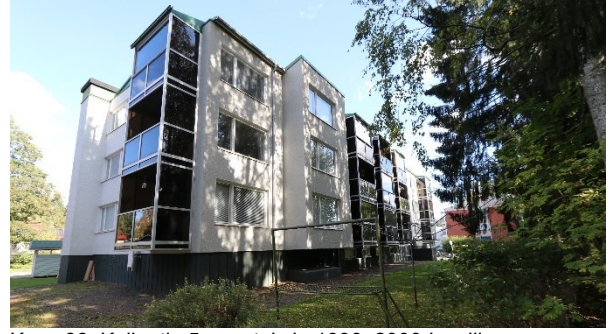
Kuva 38. Kallantie 5, muutoksia 1990–2000-luvulla.
