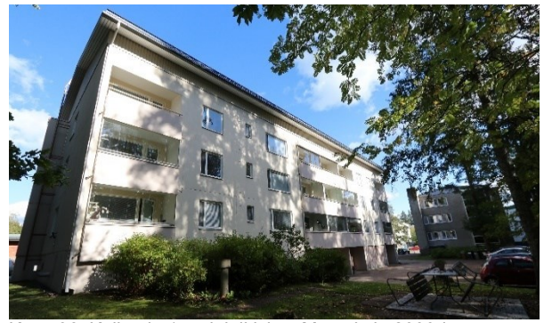
Kuva 36. Kallantie 1 eteläjulkisivu. Muutoksia 2000-l.
