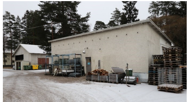
Kuva 17. Huoltamorakennus, luoteisjulkisivu. Taustalla rautavaraston rakennus. Kuva 24.11.2022.
