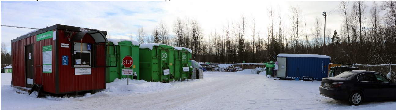
Kuva 7. Näkymä Ahlmanintien pienjäteaseman sisääntulosta. Asiakaspalvelutila sijoittuu vasemmassa reunassa olevaan konttiin.
