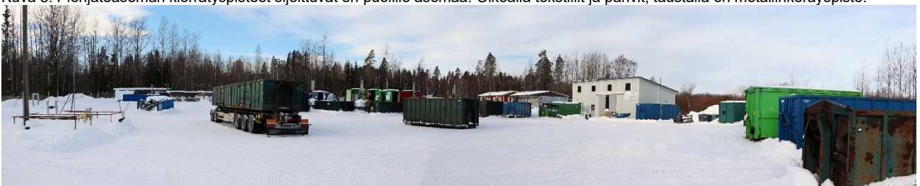
Kuva 9. Aseman alemmalla tasolla sijaitsee puutarhajätteen ja risujen vastaanotto sekä kierrätettävien rakennusosien vastaanotto. Aivan kuvan vasemmassa reunassa näkyy Kouvolan Vesi Oy:n jätevedenpumppaamo.
