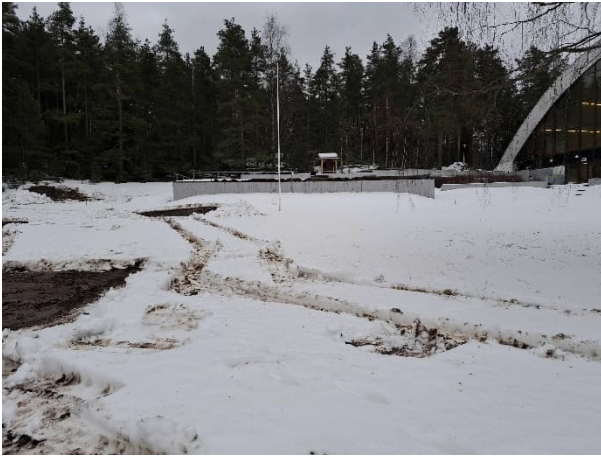
Valokuva 1. Yleiskuva tutkimuskohteesta.
