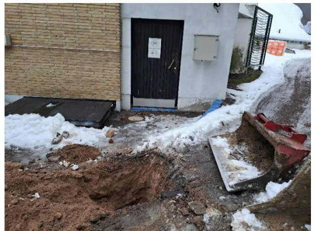
Valokuva 6. Kemikaalivaraston viereen tehtiin matala kuoppa AF8. Täyttöhiekkakerroksen alapuolelle ei päästy johtuen ahtaasta työtilasta.
