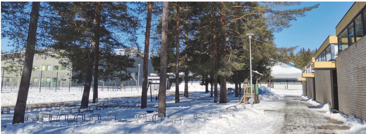
Kuva 5. Keskuskeittiön länsiosassa sijaitsee koulun nykyinen ruokala, jonka edustalla on pihan keskiosan ainoa puustoinen alue. Ruokalaan on useampi lipallinen julkisivua rytmittävä sisäänkäynti. Ikkunat on sijoitettu lähelle kattoa yhtenäiseksi nauhaksi.
