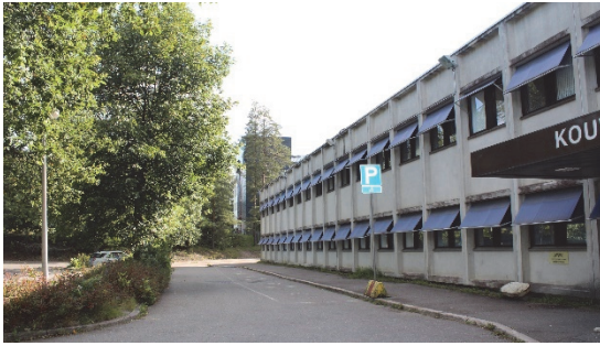
Kuva 6. Marjoniemen terveyskeskuksen Marjoniementien puoleinen julkisivu.
