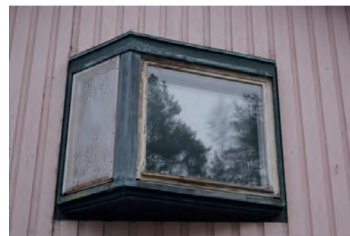
Lääkärien asunnot, julkisivun yksityiskohtia. Valokuva: Iida Hällman 12.11.2022.
