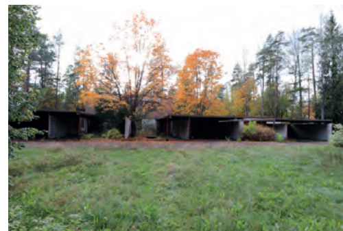
Eteläisempi rivitalo, talo 2. Julkisivunäkymä pohjoiseen. Valokuva: Hannu Purho, 8.10.2019.
