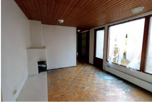
Eteläisempi rivitalo, talo 2. Asunnon F takkahuone - 1. kerros. Valokuva: Hannu Purho, 8.10.2019.
