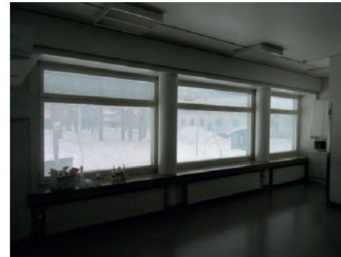
Sairaalan poliklinikan 1. kerros lasten osastonhuone. Kuvauspäivä 16.12.2022. Kuvat: Kari Mustonen
