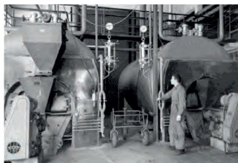
Sairaalan pannuhuone ja lämmittäjä Matti Sutelainen
