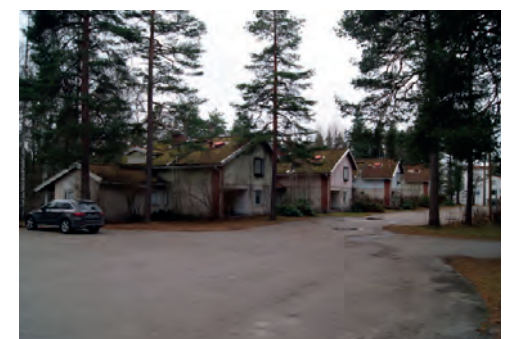
Lääkärien asunnot, julkisivuja luoteeseen. Valokuva: Iida Hällman 12.11.2022.
