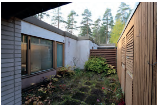
Pohjoisempi rivitalo, talo 1. Asunnon B saunapiha. Valokuva: Hannu Purho, 8.10.2019.
