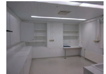
Sairaalan vanhaosan synnytysosaston lasten makuusalin ikkunasyvennykset muurattu umpeen. Kuvauspäivä 16.12.2022. Kuvat: Kari Mustonen
