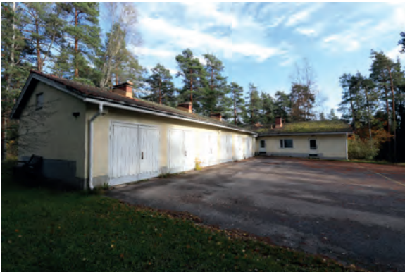
Huolto- ja autotallirakennus, julkisivuja lounaaseen ja luoteeseen. Valokuva: Hannu Purho, 8.10.2019.
