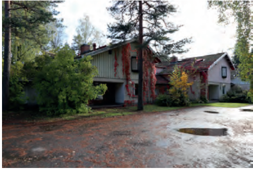
Lääkärien asunnot, julkisivuja luoteeseen. Valokuva: Hannu Purho, 8.10.2019.
