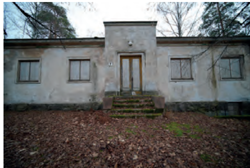
Asunnon julkisivu länteen. Valokuva: Iida Hällman, 18.11.2022.
