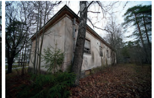
Asunnon ja autovajan julkisivuja itään ja etelään. Valokuva: Iida Hällman, 18.11.2022.
