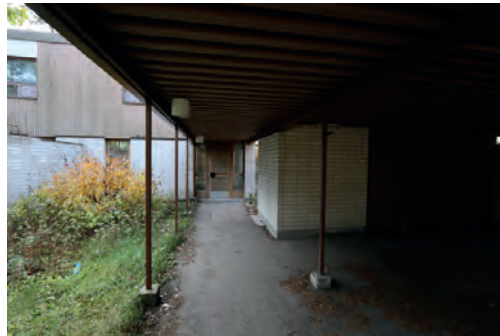
Pohjoisempi rivitalo, talo 1. Asunnon B sisäänkäynti ja autokatos. Valokuva: Hannu Purho, 8.10.2019.
