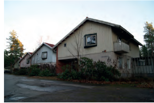
Lääkärien asunnot, julkisivuja luoteeseen. Valokuva: Iida Hällman 12.11.2022.
