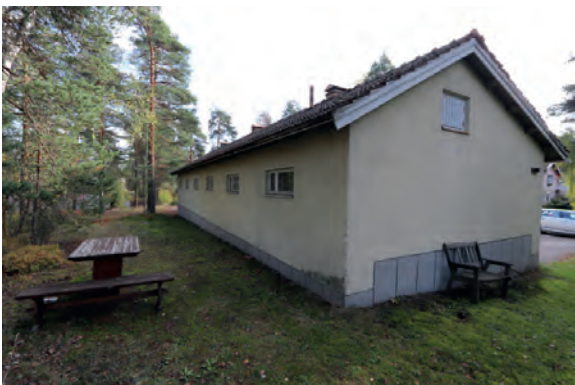
Huolto- ja autotallirakennus, julkisivuja luoteeseen ja koilliseen. Valokuva: Hannu Purho, 8.10.2019.
