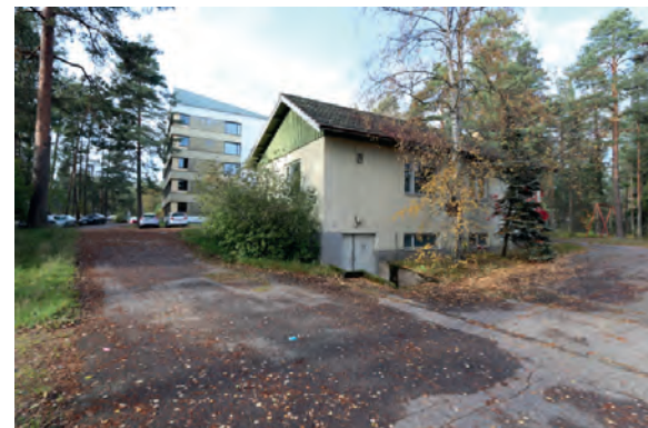
Huolto- ja autotallirakennus, julkisivuja kaakkoon ja lounaaseen. Valokuva: Hannu Purho, 8.10.2019.
