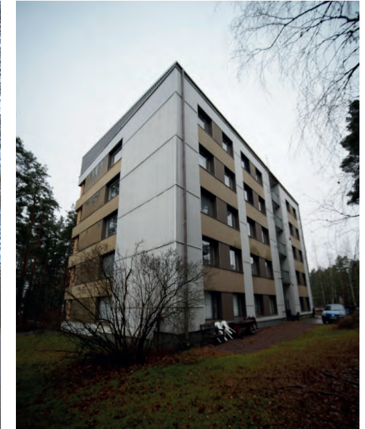
Henkilökunnan asuinrakennus julkisivuja itään ja pohjoiseen. Valokuva: Iida Hällman, 18.11.2022.
