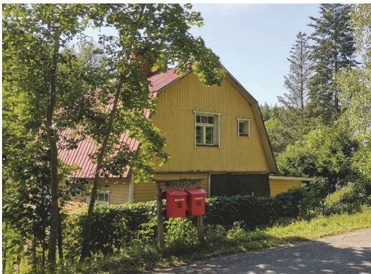
Kuva 5. Pohjoistien varressa sijaitseva mansardikattoinen asuinrakennus.
