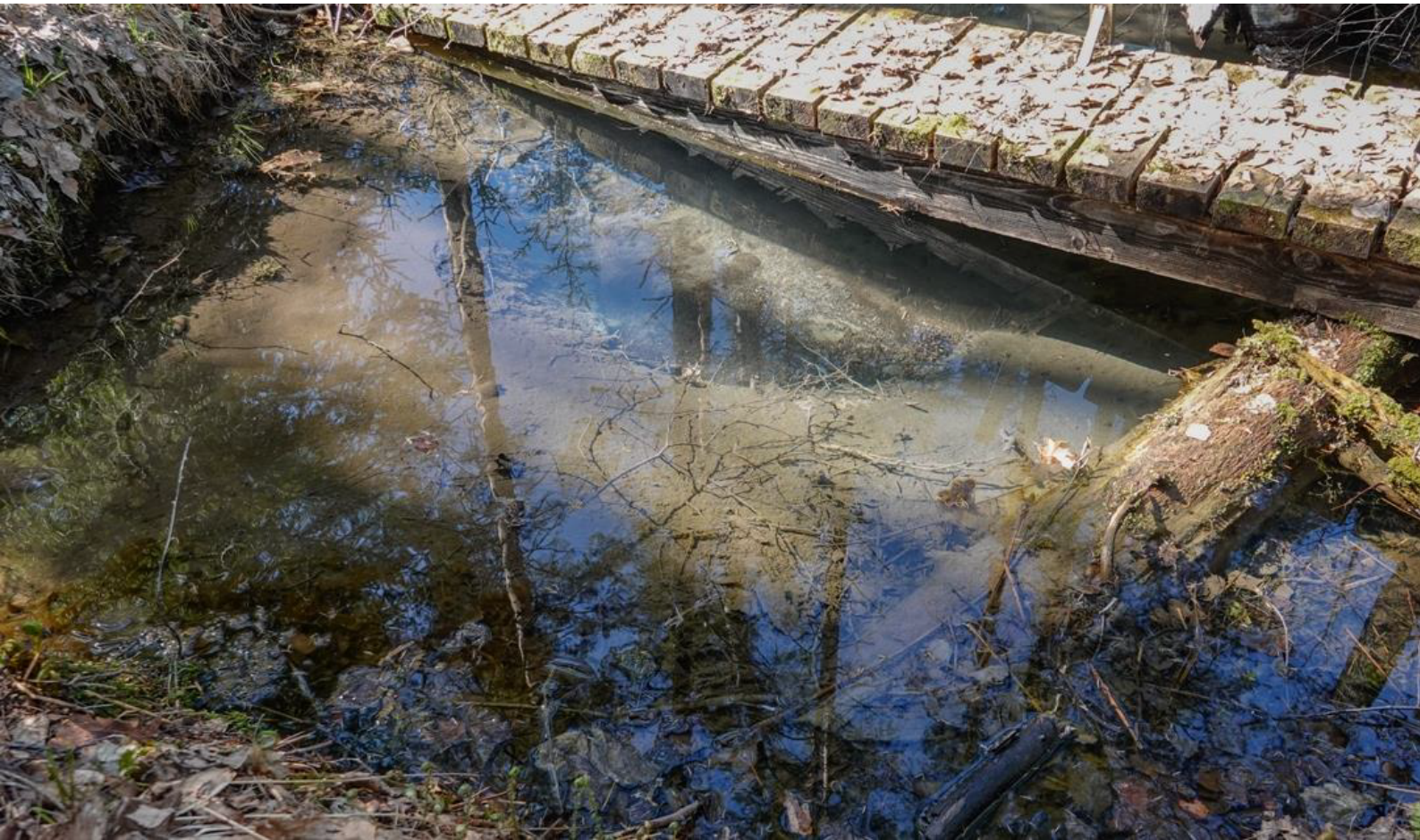
Kuva 21. Hossinhiekan lähde ja sen yli rakennettu lahonnut silta. 10.5.2018 © Petri Parkko
