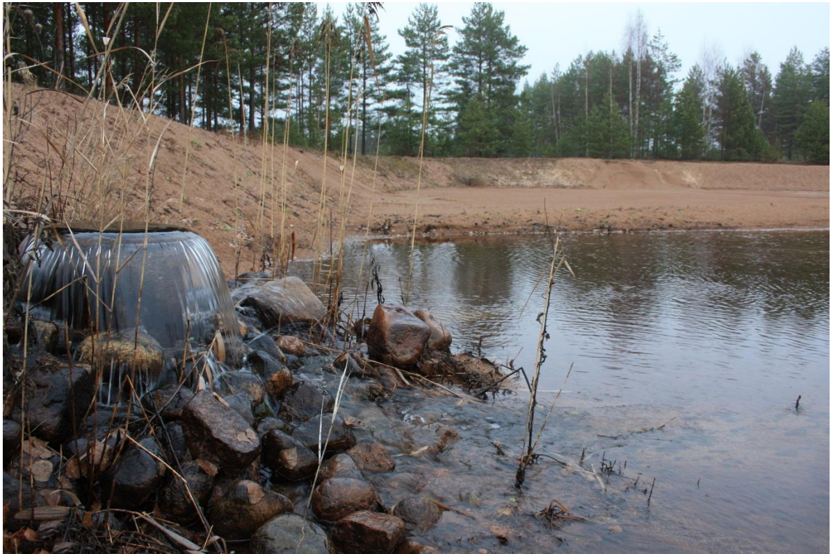
Kuva6.7. Kuivalan tekopohjavesilaitoksen imeytysallas.
