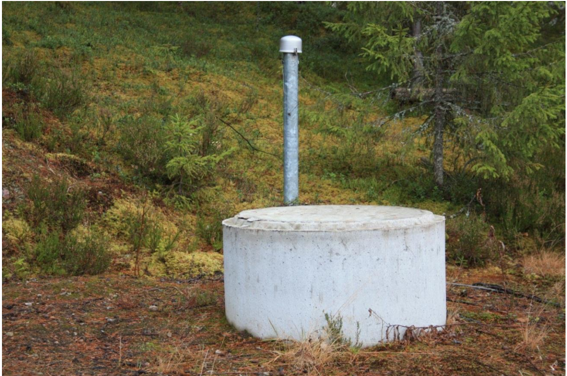
Kuva 6.8.Haimilaan rakennettu varakaivo K17.
