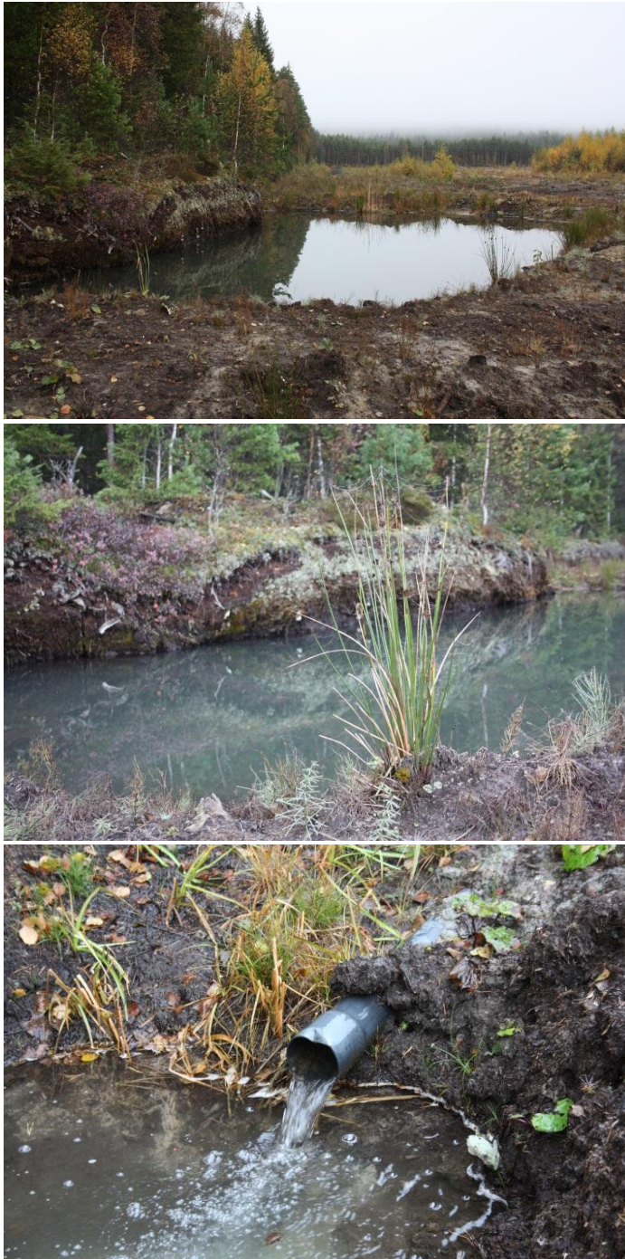
Kuva 5.3. Mustamännikkö Utin eteläreunassa, lähteet ovat osin jääneet turvetuotantoalueelle ja pohjaveden pinta on laskenut lammissa. Lähdelampiin purkautuva pohjavesi johdetaan turvetuotantoalueen ojiin purkuputkella.
