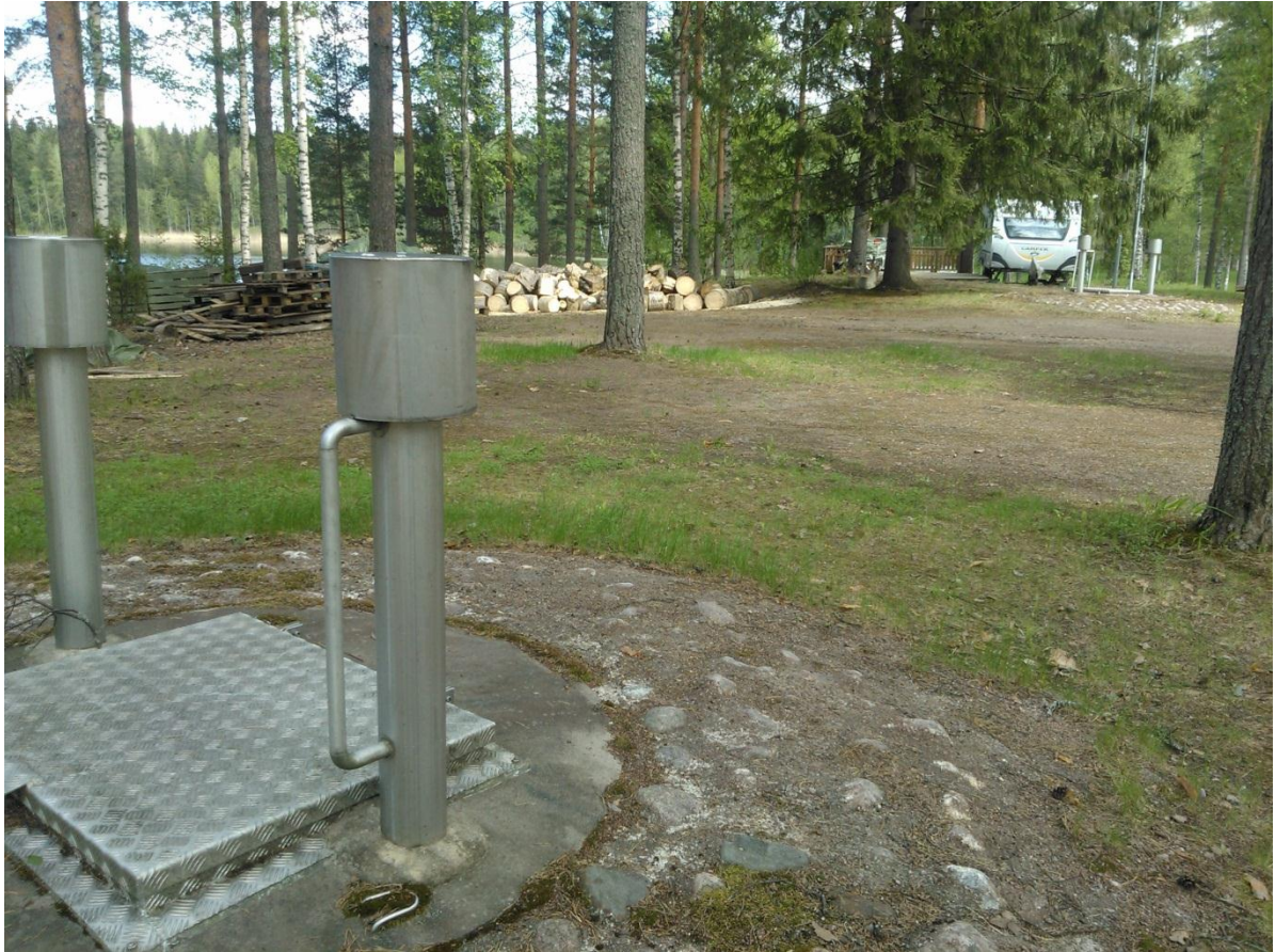
Kuva 5.2.2. Käyrälammen vedenottamon leirintäalueella olevat kaivot eivät ole nykyään käytössä.
