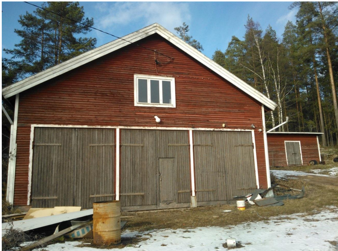
Kuva 6.5.1.1. Tiemestaripiirin tukikohta. Rakennuksen takana on erillinen suolavarastovaja. Ruhmaanharjun pohjavesialue.
