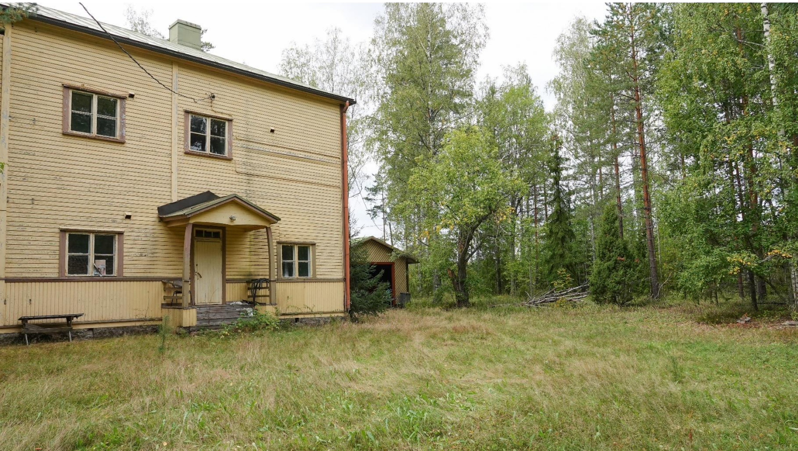
Kuva 9. Hillosensalmen kohteella 2 sijaitsee vanha koulurakennus, joka on ilmeinen lepakkokohde. Hillosensalmi 16.9.2021 © Petri Parkko
