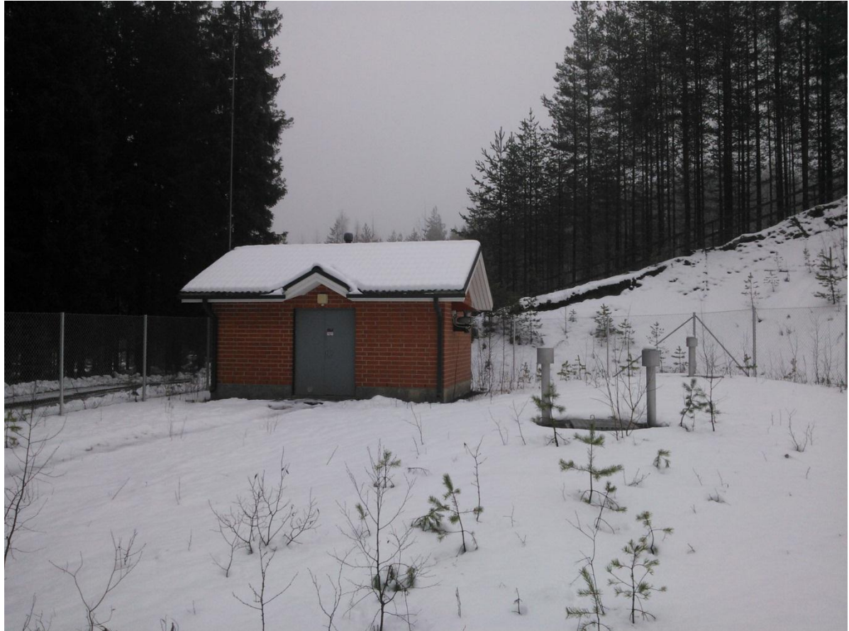
Kuva 5.1.2. Kaipiaisten uusi vedenottamo.
