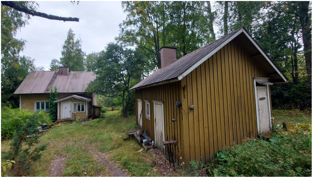
Kuva 8. Kaava-alueella oleva rakennuspaikka.
