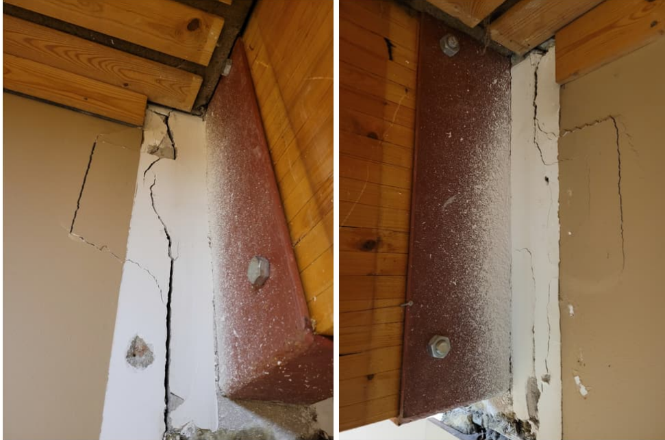
Kuva 4. Kattopalkin liitos elementtisaumassa
