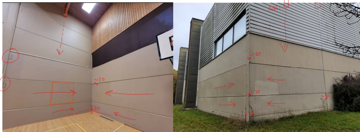
Kuva 1. Painumat ja siirtymät sisältä ja ulkoa
