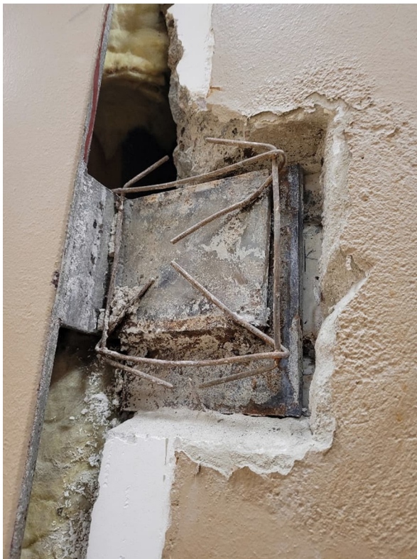
Kuva 3. Ulkoseinän sandwich-elementin ja teräspilarin välinen liitos
