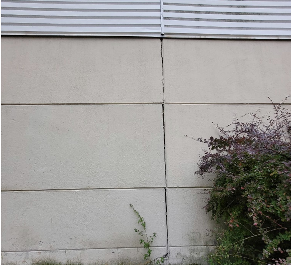
Kuva 6. Elementtien pystysauma rakennuksen ulkopuolelta
