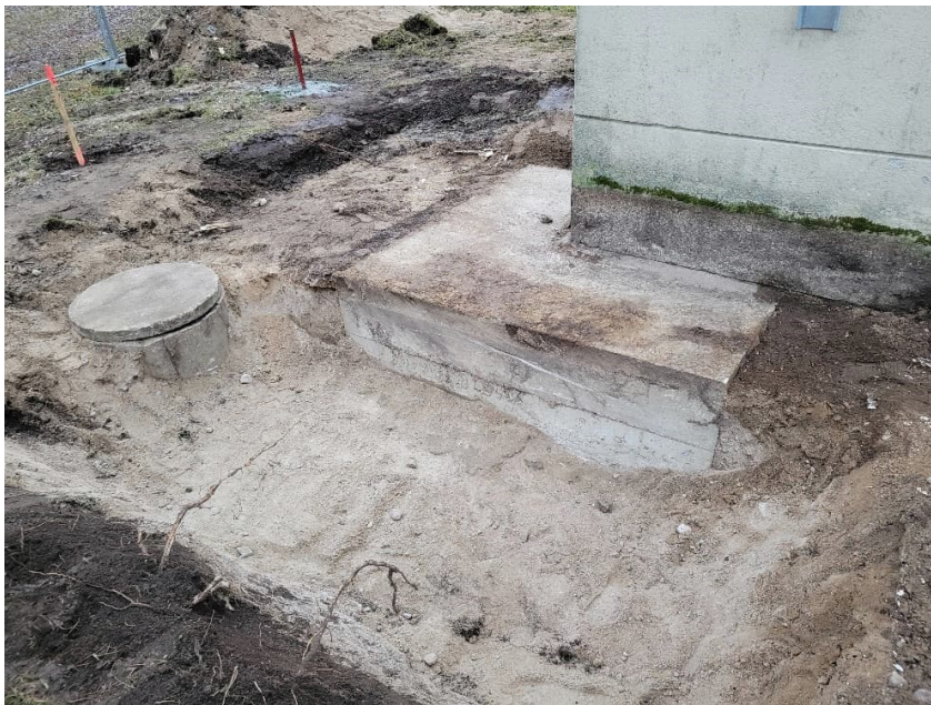
Kuva 5. Rakennuksen nurkan perustus
