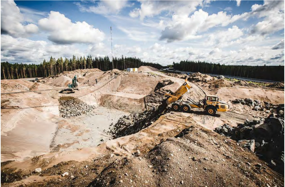
Kuva 3. VT12 rakennustyömaa 30.8.2018 (Kuva: Jari Heikkilä)
