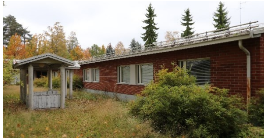
Kuva 8. Eteläjulkisivua ja piharakennelma.
