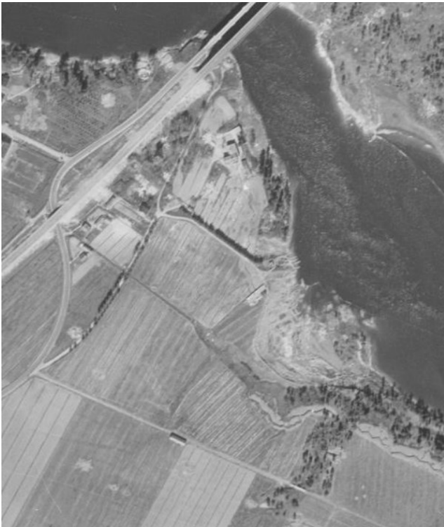
Kuva 18. Ilmakuva Korian Kallioniemen alueelta vuodelta 1941. Kuvassa näkyvät Kymijoen rantapenkereen sortuma-alue ja sen vieressä sijainneet Kymijokilinnan taisteluhaudat ja raviini. Suunnittelualue on suurimmalta osaltaan vielä rakentamaton. Ainoat rakennukset alueella olivat tuolloin eläintalon vanhan päärakennus ja sen vieressä tälläkin hetkellä sijaitsevat rakennukset. Radan varressa on kuvassa näkyvillä jonkinlainen tornimainen rakennus. Tanssilavaa ei vielä ole toteutettu ja Korian Ponsi ry:n nykyisen toimitilan paikalla oleva vanha asuinrakennus on vielä paikallaan. Koriantien varrella oleva pommikuoppa näkyy myös kuvassa. Kuvalähde: Maanmittauslaitos, Paikkatietoikkuna, vierailtu 2.2.2022.
