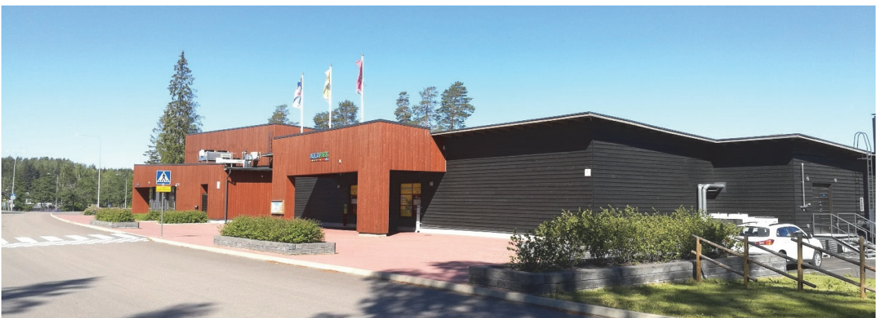
Kuva 7. Vesipuiston sisätilat sijaitsevat kaikki yhdessä rakennuksessa puiston etelälaidalla.
