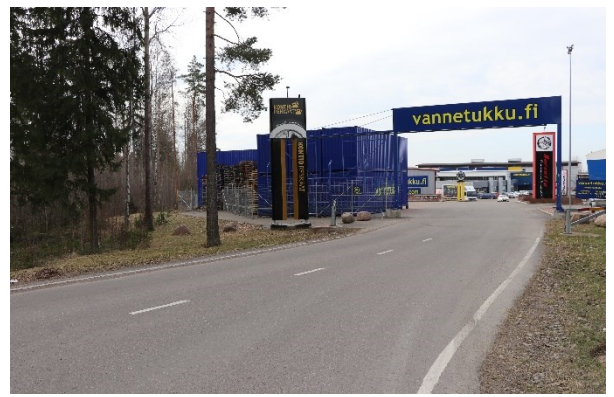
Kuva 15. Näkymä Hitsaajantien katualueelta kohti Vannetukun sisääntuloporttia. Viheralueet ovat osa katualuetta.
