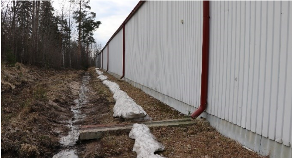
Kuva 6. Vannetukun hulevedet kulkeutuvat ojaa pitkin etelään.
