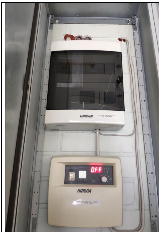
Kiukaan kontaktorikotelo ja ohjauskeskus
