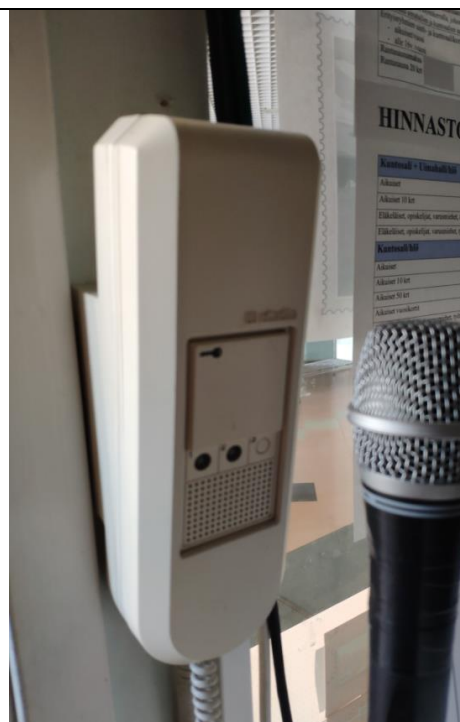
Ovipuhelimen vastauskoje lipunmyynnissä
