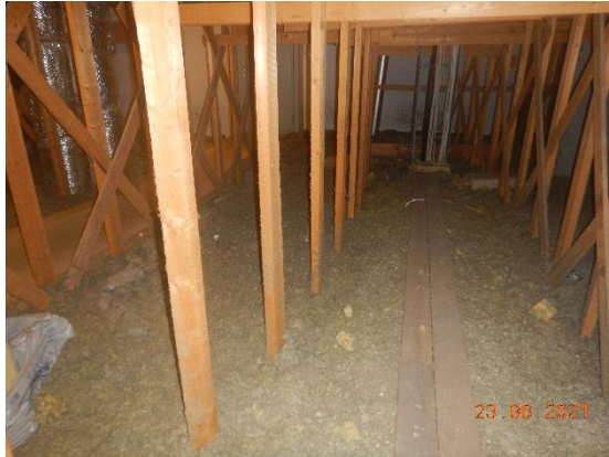
Kuva 81 Tuulettuvan yläpohjatilan lämmöneristeenä on puhallusvilla.
