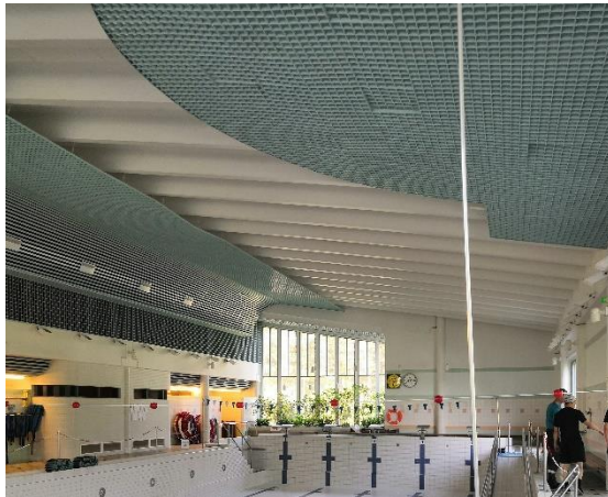
Kuva 87 Allasosastolla yläpohjarakenne on TT-laatasto.
