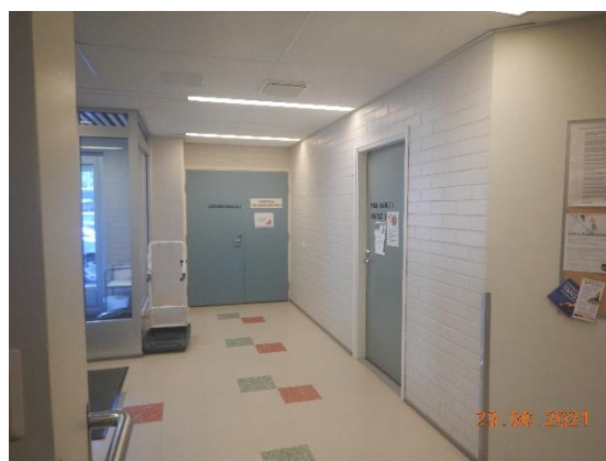
Kuva 24 Ensimmäisen kerroksen (huolto-kerros) aulassa on vinyylilaatoitusta.
