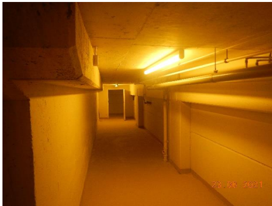
Kuva 27 Altaiden huoltokäytävien maanvastaisissa seinissä ei havaittu kosteuden aiheuttamia vaurioita. Allasrakenteet on käsitelty tarkemmin erillisessä betonirakenteiden kuntotutkimuksessa.
