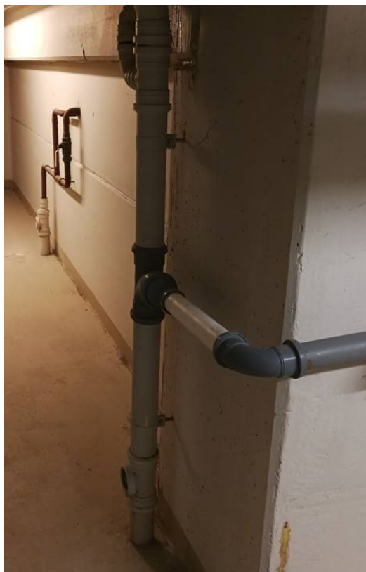
Kuva 5. Esimerkki viemärijohdoista.
