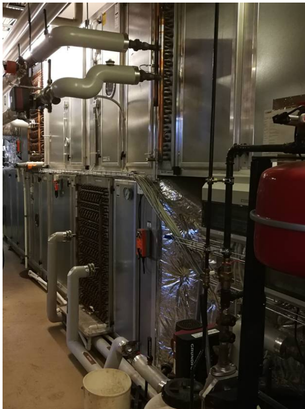
Kuva 8. Allastilan ilmanvaihtokone.
