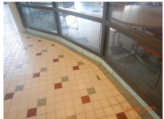
Kuva 66 Allasosastolla on keraamista laatoitusta. Väliseinä aulan välillä on ikkunaelementtirakenteinen.
