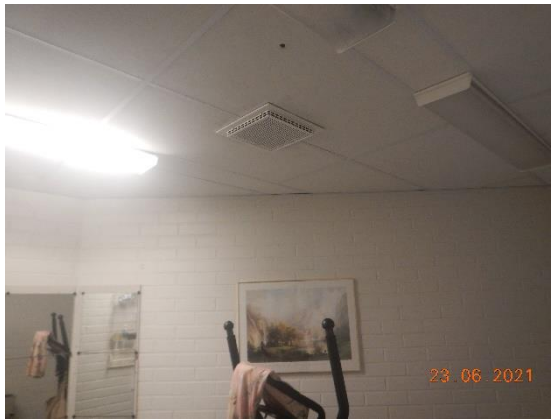
Kuva 91 Akustiikkalevytetty alakatto fyysioterapeutin toimitiloissa.
