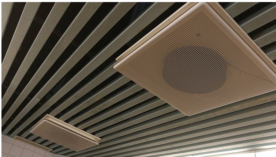
Kuva 11. Esimerkki ilmanvaihdon päätelaitteesta.
