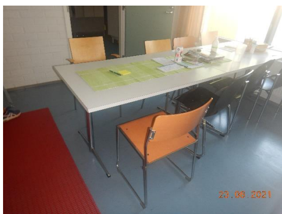
Kuva 25 Henkilökunnan sosiaalityloissa on muovimattoja, mikä on nostettu seinälle.
