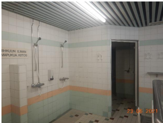
Kuva 93 Pesuhuoneissa on metallisäleikkö-alakatot.
