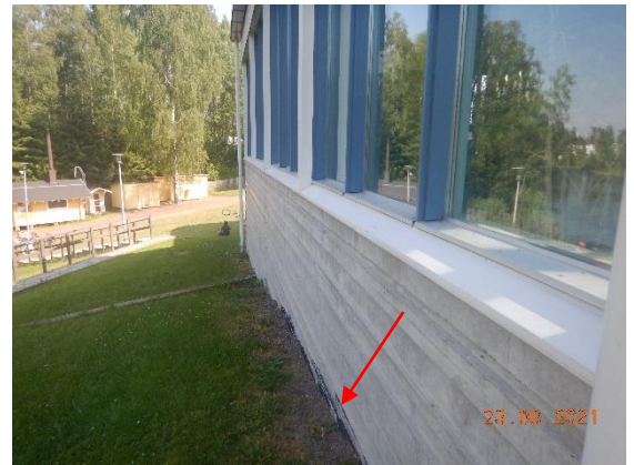
Kuva 28 Sokkeleissa havaittiin ulkopuolisen vedeneriste (bitumisively).
