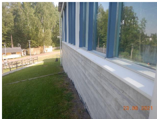
Kuva 45 Allasosaston ikkunat sijoittuvat muita ikkunoita syvemmälle, joten niissä on ns. tuplapellitys.
