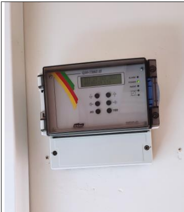
Pääkello on asennettu liikuntasiiven puolelle
