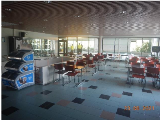
Kuva 63 Aulassa 239 välipohjan pintamateriaalina on keraaminen laatoitus.
