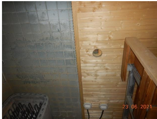
Kuva 67 Naisten sauna on jossakin vaiheessa saneerattu, mutta kiukaan takainen väliseinä on jo pinnoiltaan hyvin kulunut.
