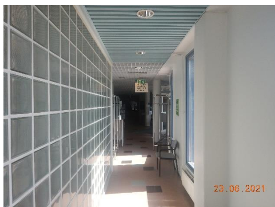
Kuva 19 Käytävällä ja aulassa lattian pintamateriaalina on keraaminen laatoitus.
