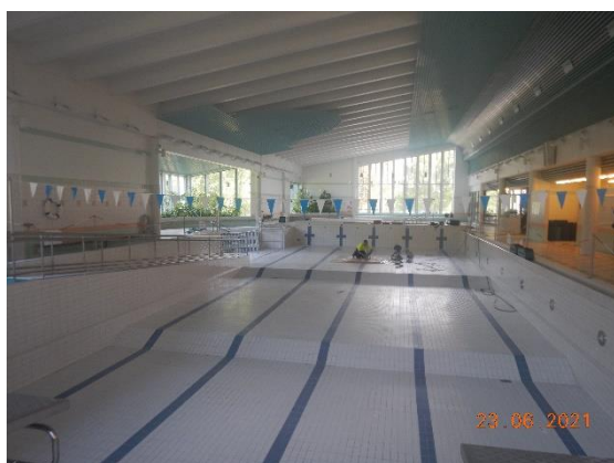
Kuva 23 Altaissa on keraaminen laatoitus. Erillistä vedeneristettä ei lähtötietojen mukaan ole. Allastilat ja laatoitusten kopokartoitus on käsitelty tarkemmin erillisessä betonirakenteiden kuntotutkimuksessa.
