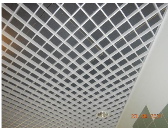
Kuva 95 Verkkorakenteisen alakaton yllä on mustia akustiikkalevyjä, joiden reunat ei ole pinnoitettu.
