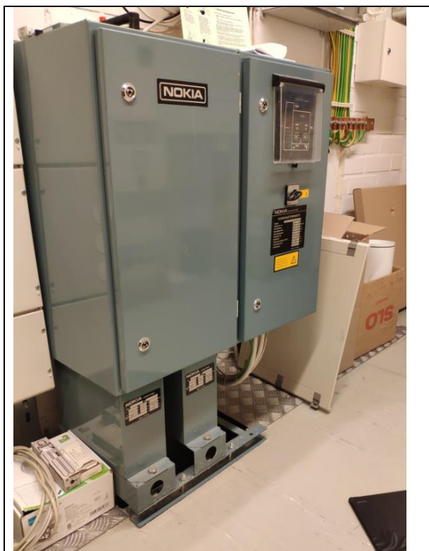
Kompensointilaitteisto
