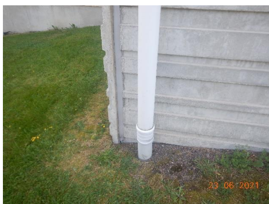
Kuva 10 Vesikaton sadevedet ohjautuvat suoraan maanalaiseen sadevesijärjestelmään.
