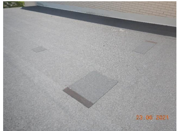
Kuva 86 Kuva kermikatteesta on muualta osaa Valkealataloa, jonka katon kautta tapahtuu kulku uimahalliosan katoille. Kermikatot olivat pääosin siistikuntoiset, paikkauksia havaittiin.
