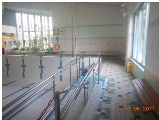
Kuva 53 Allastiloissa seinillä on keraaminen laatoitus.
