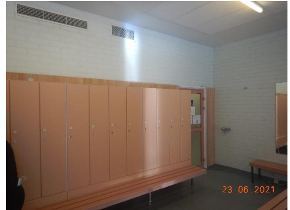
Kuva 64 Väliseinät ovat pääosin maalattuja tiiliseiniä.
