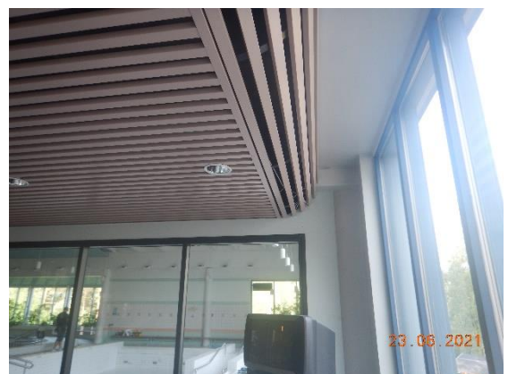
Kuva 90 Aulassa on sekä säleikkö- että verkkorakenteisia alakattoja.
