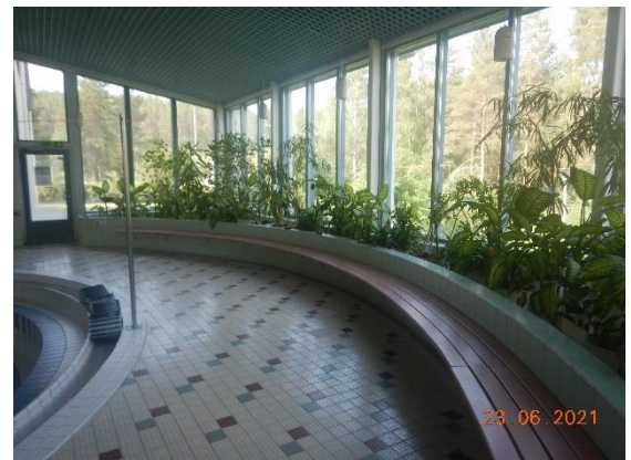
Kuva 76 Allastilan välipohjassa on kohonneita pintakosteuden vertailuarvoja laajalti, mikä on normaalia laatoitetuissa märkätilapinnoissa.
