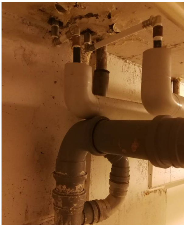
Kuva 4. Esimerkki vesi- ja viemärijohdoista.
