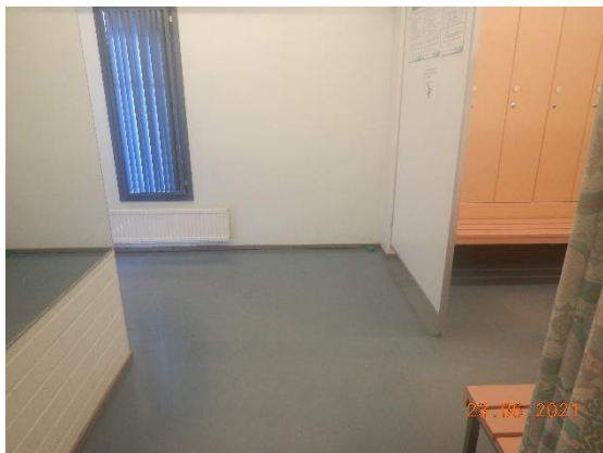
Kuva 52 Maalattu kipsilevyseinä naisten pukuhuoneessa 260.
