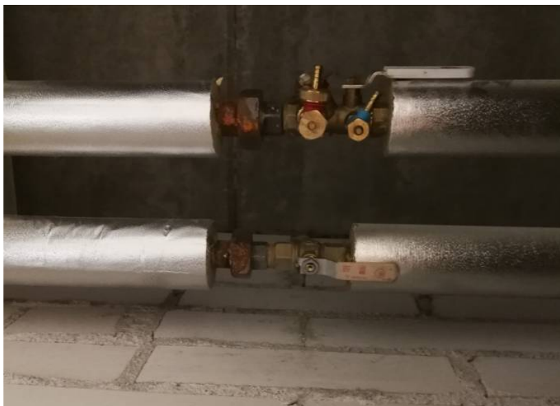
Kuva 2. Esimerkki lämpöjohtojen sulku- ja linjasäätöventtiileistä.
