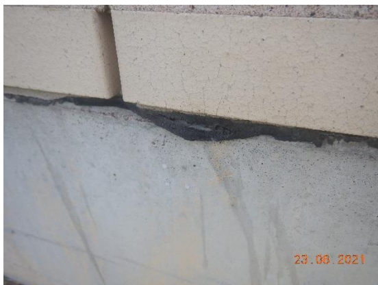
Kuva 31 Sokkelielementin ja ulkoseinämurauksen välissä on bitumikaista.
