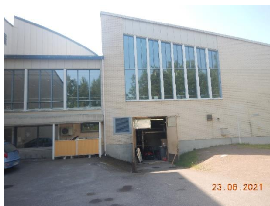
Kuva 11 Pohjoispäädyssä on asfaltoitu luiska huoltotiloihin.
