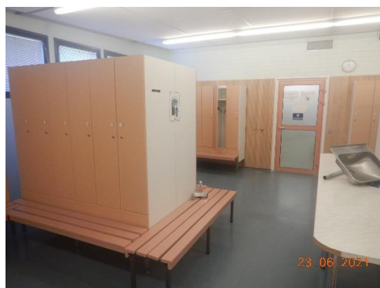
Kuva 20 Pukuhuoneissa on käytetty muovimattoja.
