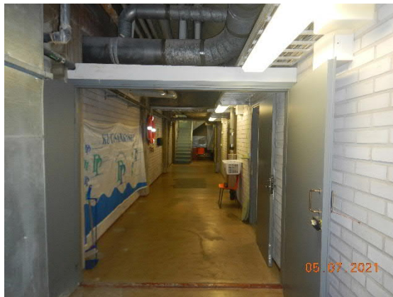
Kuva 24 Teknisen pohjatasen käytävällä alapohjan pintamateriaalina on massalattia.
