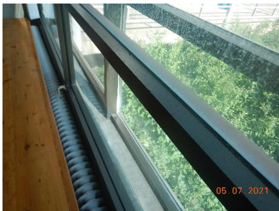
Kuva 60 Ikkunat ovat eristyslaselementtejä.
