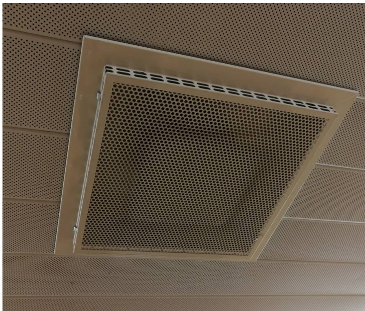
Kuva 13. Esimerkki tuloilman päätelaitteesta.
