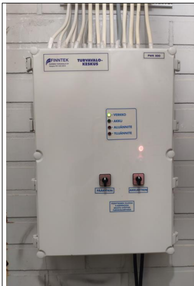
Keskus resonoi voimakkaasti akkukäytöllä
