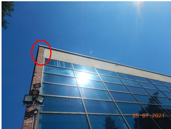
Kuva 44 Lounaissivulla ylimmissä ikkunoissa on veden valumajälkiä. Länsinurkan tiilimuuraus on kallistunut ulospäin sandwich-elementistä.
