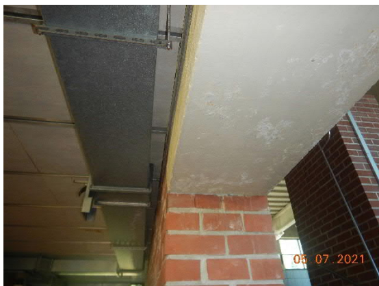
Kuva 85 Allasosaston ja luoteisen portaikon välisessä väliseinässä, aukonylityspalkissa ja alakattopinnoissa havaittiin paljon kosteuden aiheuttamia jälkiä.
