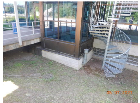
Kuva 59 Koillissivun sinkitty kierreportaikko on hyväkuntoinen.
