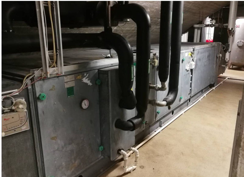
Kuva 12. Ilmankuivatuskone allaslaitetilassa.
