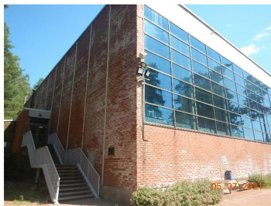
Kuva 43 Kalkkihärmää on erityisesti lou-nais- ja luodesivuilla.
