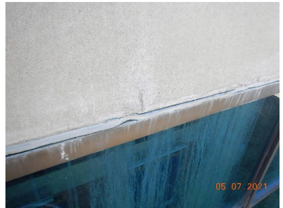
Kuva 57 Epätiivis ikkunaliittymä.
