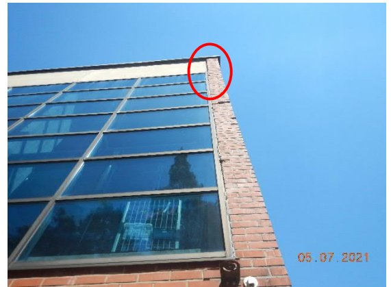
Kuva 45 Vastaavanlainen kallistuma etelänurkalla.
