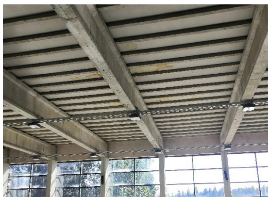
Kuva 112 Allasosastolla on näkyvillä yläpohjan vuotojälkiä. Vesikatolla ei kuitenkaan havaittu jälkien kanssa yhteneväisiä kohtia, joista vuotoja olisi voinut tapahtua. On mahdollista, että vuotojäljet ovat vanhempia.
