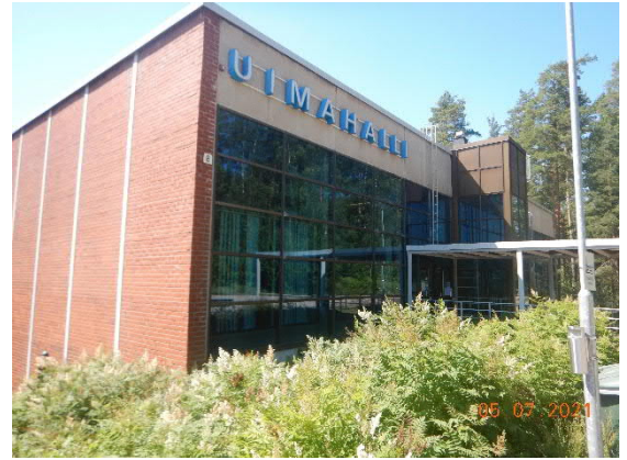
Kuva 51 Rakennuksen itänurkka. Kaakkoissivulla on selkeästi vähemmän kalkkihärmää kuin lounais- ja luoteissivulla.
