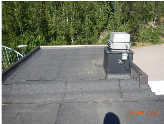
Kuva 107 Vuoden 1995 peruskorjauksessa rakennetun hissien vesikatto on hyvässä kunnossa ja limitys vanhaan vaikuttaa tiiviiltä.
