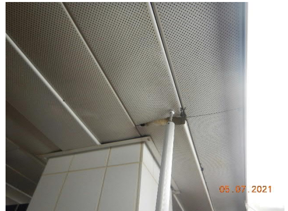
Kuva 82 Säleikköjen yläpuolella on mineraalivillaa.
