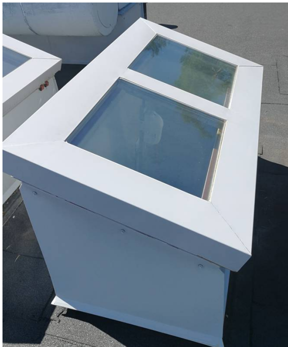
Kuva 16. Savunpoistoluukku vesikatolta kuvattuna.
