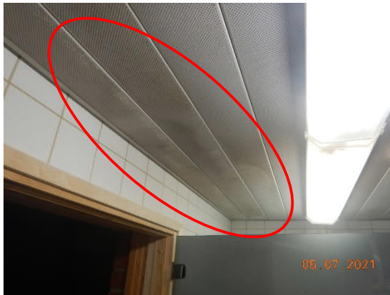
Kuva 81 Kosteusjälkiä metallisäleikköalakatossa.
