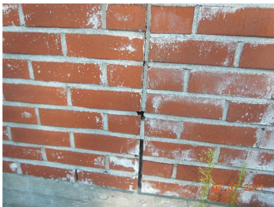
Kuva 48 Muuraussaumot ovat paikoin rapautuneet.
