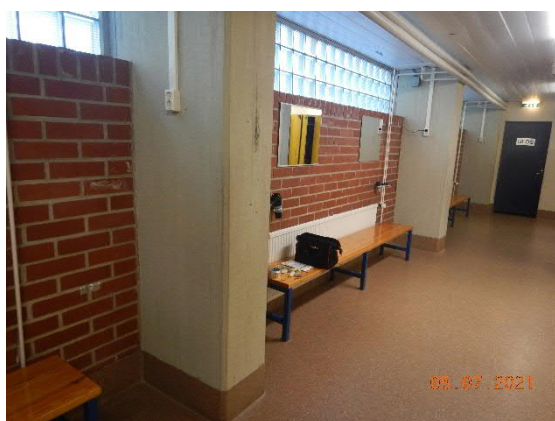
Kuva 68 Pukuhuonetilojen osin maanvastaiset ulkoseinät ovat siistit.
