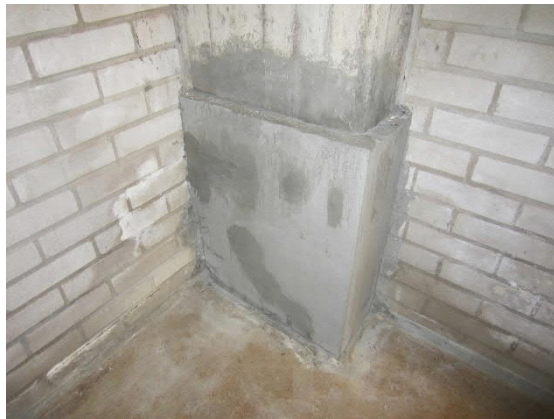
Kuva 28 Vaurioikorjattu pilari.
