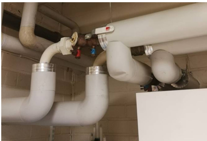
Kuva 2. Esimerkki lämmityksen paluujohdon linjasäätöventtiilistä.
