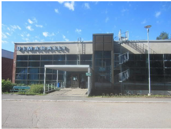
Kuva 52 Koillissivu on pääosin ikkuna- ja sandwich-elementtejä. Pukuhuonekerroksen lasitiili-ikkunat ovat alimpana.
