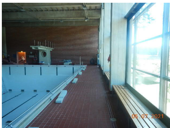
Kuva 66 Allasosaston pilarit ovat siistit.
