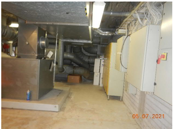
Kuva 25 Maalattua betonilattiaa IV-konehuoneessa.
