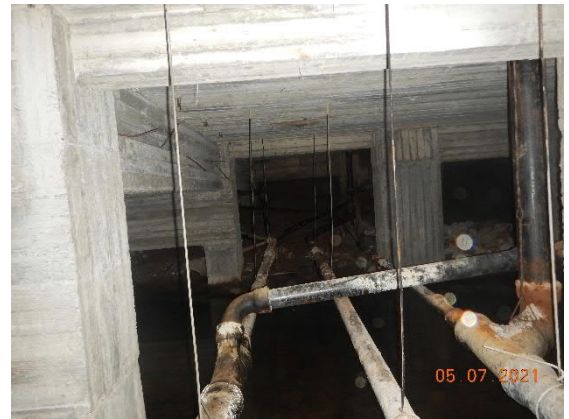
Kuva 23 Alapohjatilassa on pohjaviemärit.
