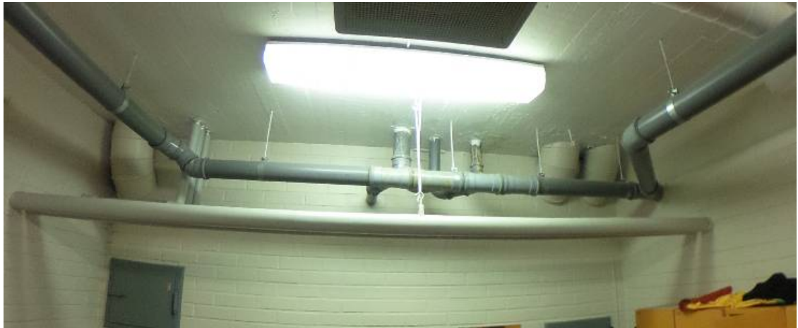
Kuva 7. Esimerkki uusituista muoviviemäreistä tekniikkakerroksessa.
