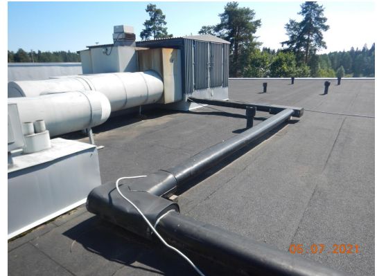
Kuva 106 Yleiskuuvaa vesikatolta. Vesikatolla on pieni IV-konehuone ja läpivientejä lähinnä yläpohjatililan tuuletusputkille.
