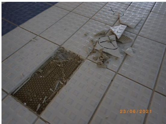
Kuva 10 Kopojalaattoja oli merkattu valmiiksi. Yksi laatta irrotettiin tarkasteltiin laatan alapuolisia kerroksia.
