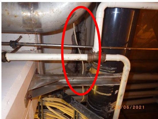
Kuva 29 Altaan runkolaatassa havaittiin paikallisia lohkeamia.
