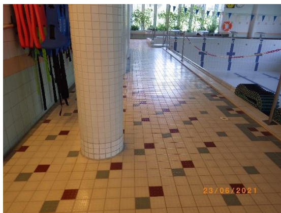
Kuva 36 Yleiskuva lattian laatoituksesta. Pilarin alaosista on uusittu monin paikoin laatoituksia.
