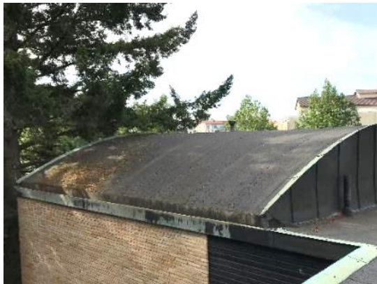
Kuva 96. Sammalkasvustoa kuntosalin kaarevalla katolla
