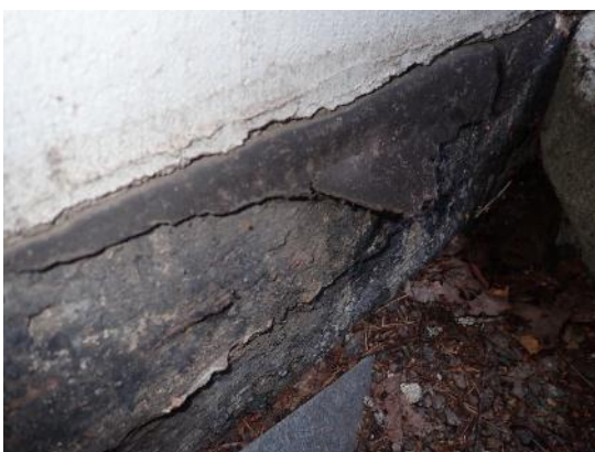
Kuva 40. Vanha ulkoseinän vedeneristyskermi näkyvissä korjatun sokkelirakenteen ja maanvastaisen ulkoseinän välissä
