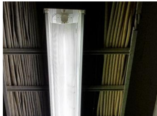
Kuva 144. Rikkoutunut valaisinkupu
