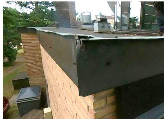
Kuva 99. Reikä räystäään kulmassa
