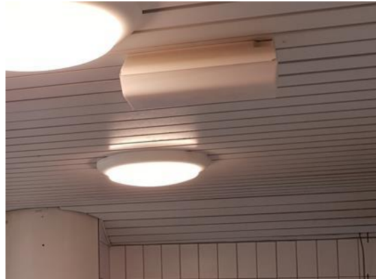
Kuva 146. Rikkoutunut valaisinkupu
