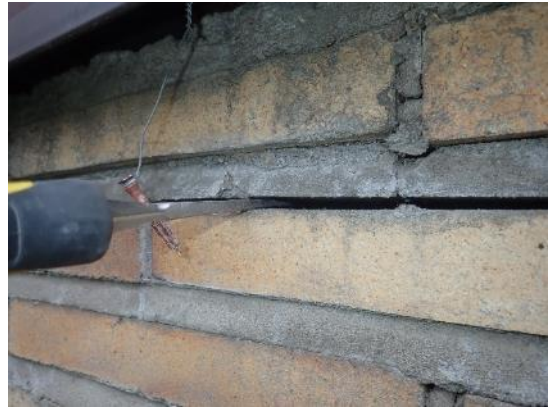
Kuva 25. Heikosti tiilessä kiinni oleva laastisauma
