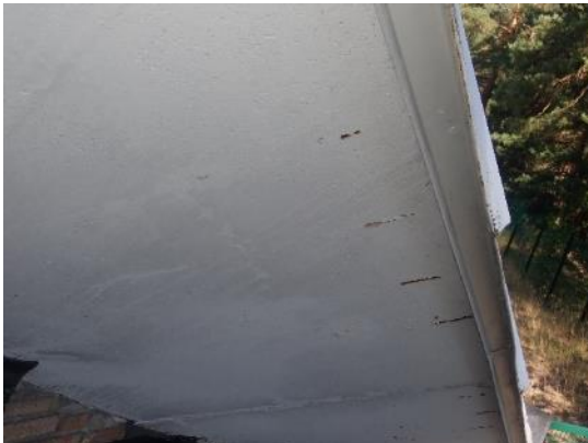
Kuva 32. Näkyviä raudoitteiden korroosiovauroita betonikaaren pinnalla
