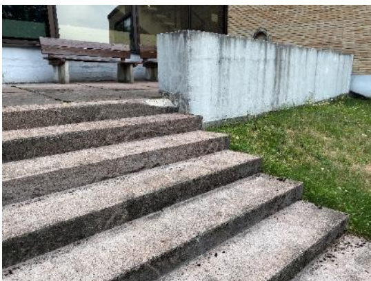
Kuva 120. Betoniportaat allashuoneen edustalla
