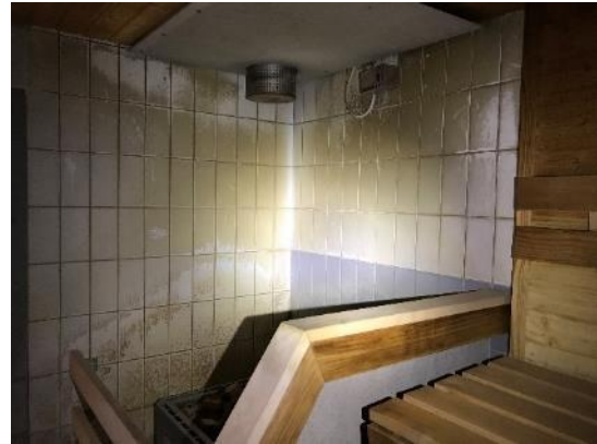
Kuva 79. Värjäymiä ja pinttyneitä tahroja kiukaan taustalaatoituksessa
