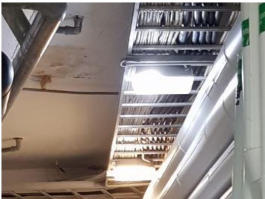
Kuva 143. Rikkoutunut valaisinkupu
