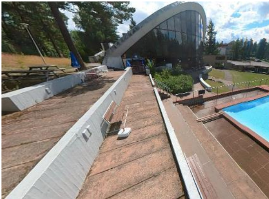
Kuva 118. Betoinitukimuureja ja paikallavalettuja betonilaattoja
