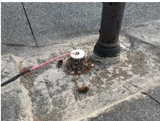
Kuva 94. Kattokaivon syvennyksessä viemärin tuuletusputken läpivienti
