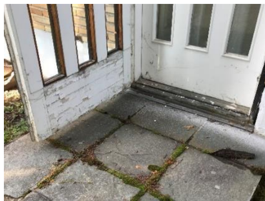
Kuva 43. Heikkokuntoinen puu-ulko-ovi
