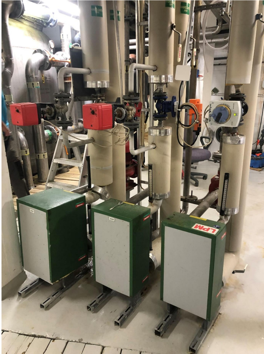
Kuva 4 Lämmönvaihtimet.
