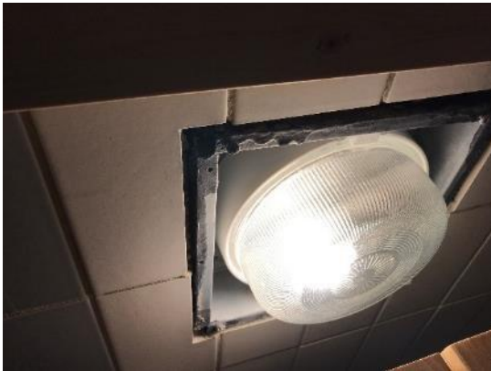
Kuva 124. Viimeistelelemätön saunan valaisimen ympärys
