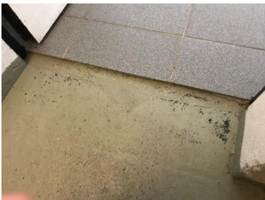
Kuva 72. Vanhaa mustaa pikimäistä ainetta lattiassa, komero p03
