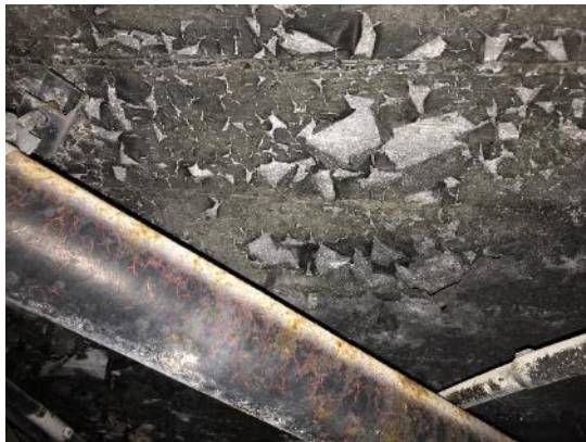
Kuva 64. Pesuhuoneen p06 alakattotilan hilseilevää pinnoitetta
