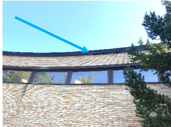
Kuva 27. Ylimmältä tiiliriviltä pudonnut tiiliä
