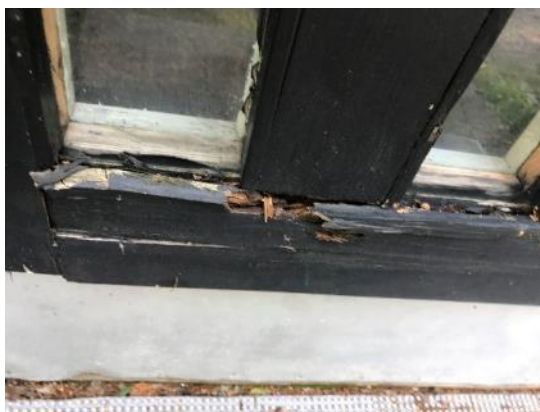
Kuva 42. Laho puu-ulko-ovi
