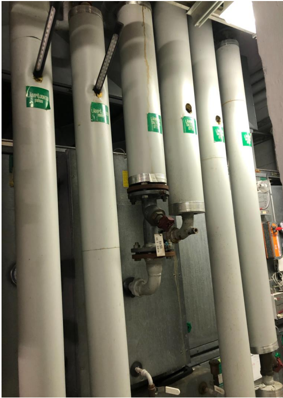
Kuva 131. Lämpöjohtojen muovipinnoitteiset villakourueristeet
