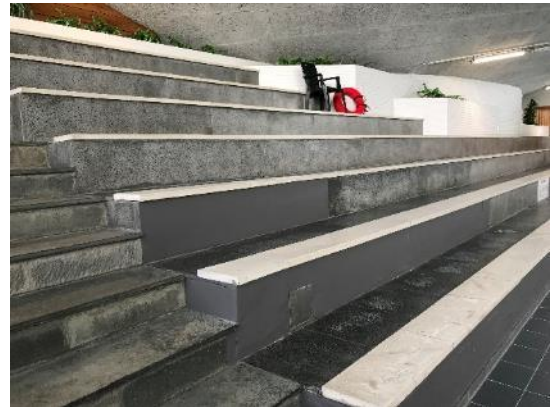
Kuva 125. Katsomopenkkien alkuperäistä ja korjattua pintaa
