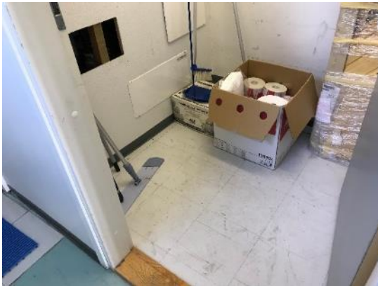
Kuva 80. Avoin koteloinnin luukku, varasto käytävän p11 vieressä
