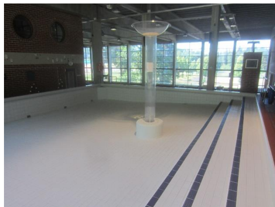
Kuva 25 Laatoitukset ovat tyydyttävässä kunnossa, vaurioita ei havaittu.
