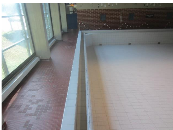
Kuva 26 Loiskekoururakenteen pinnat on altaan ohella saneerattu vuonna 2011.
