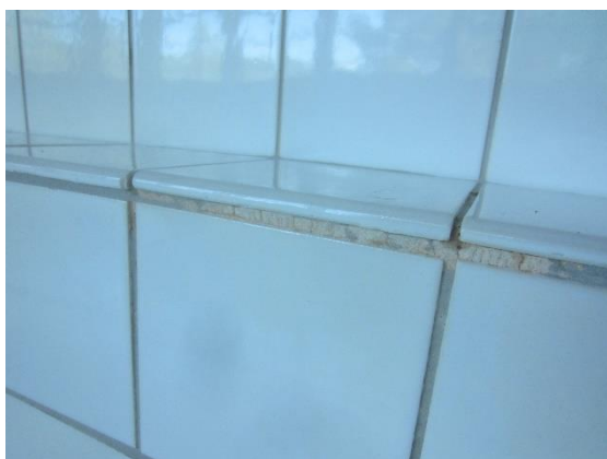
Kuva 17 Laattojen saumoissa todettiin vain yksittäisiä saumojen vaurioita.
