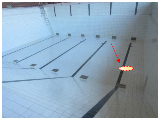
Kuva 14 Ainoa pieni kopoalue todettiin syvässä päädyssä matalan hyppytason edessä.
