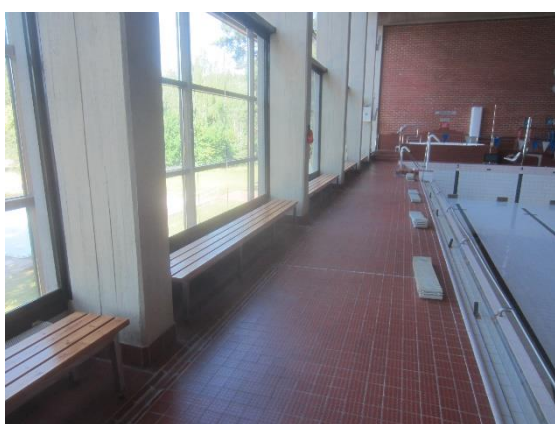
Kuva 46 Allastilojen pilarit ovat tyydyttävässä kunnossa.
