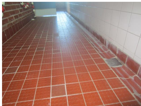
Kuva 33 Laattojen pinnat ovat kohokuvioisia.
