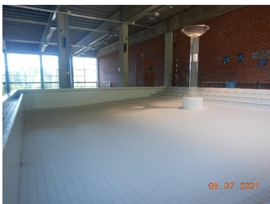
Kuva 28 Altaan laatoitukset ovat hyvin kiinni alustassaan.
