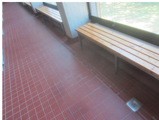
Kuva 39 Laattojen saumoissa ei havaittu merkittäviä vaurioita.
