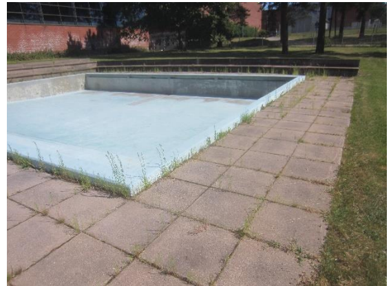
Kuva 55 Ulko-altaan reuna-alueet ovat vanhentuneita ja laatoitusten raoista kasvaa kasvillisuutta.
