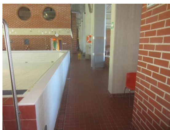
Kuva 47 Pilareissa ei todettu vaurioitumista.
