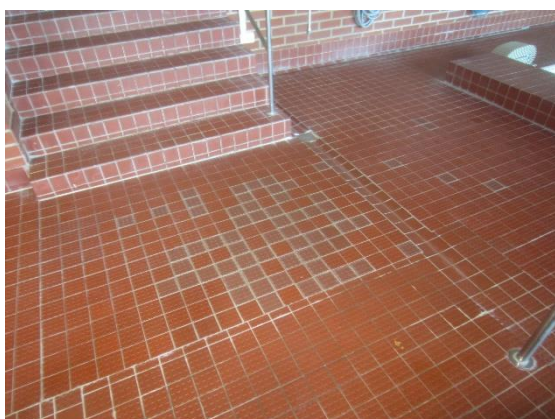
Kuva 36 Laatoituksia on uusittu paikallisesti molemmilla allastasoilla.
