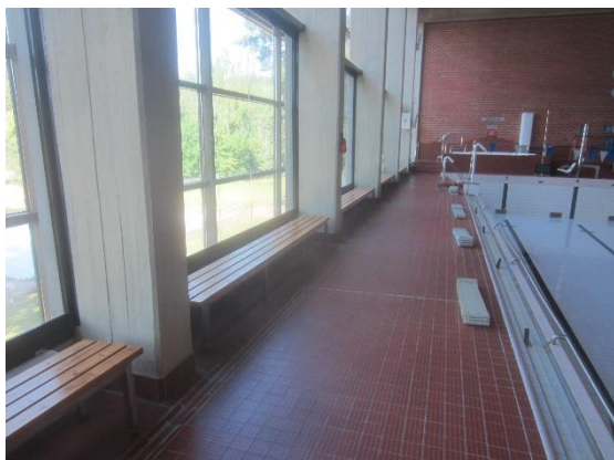
Kuva 32 Allastilojen tasopinnat ovat laatoitettu keraamisilla laatoilla.
