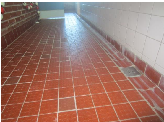
Kuva 38 Laattojen saumoissa ei havaittu merkittäviä vaurioita.
