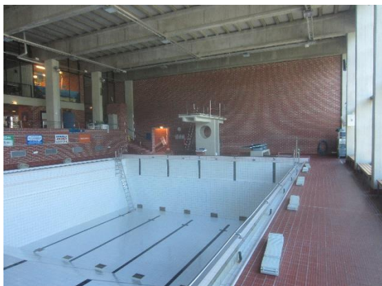
Kuva 34 Kopoa laatoitusta todettiin vain yksittäisiä kohtia.
