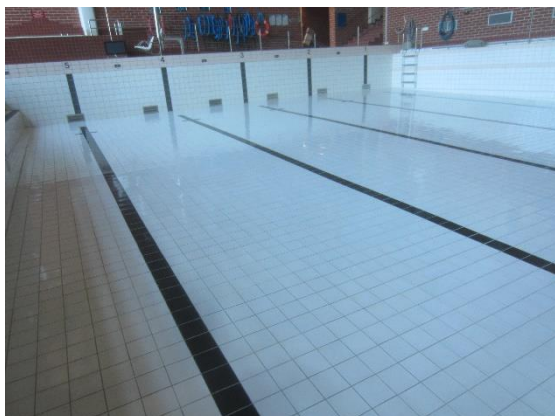
Kuva 13 Altaan laatoitukset ovat hyvin kiinni alustassaan.
