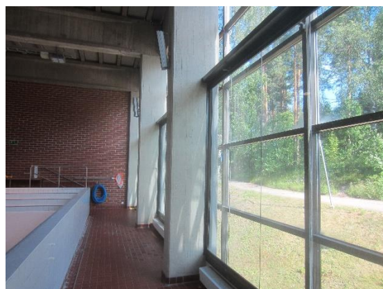
Kuva 49 Lasten altaan viereisiä pilareita on tutkittu aiemminkin.
