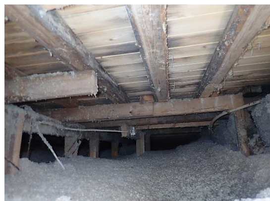
Kuva 63. Yläpohjarakenteet aulan/miesten saunan kohdalla
