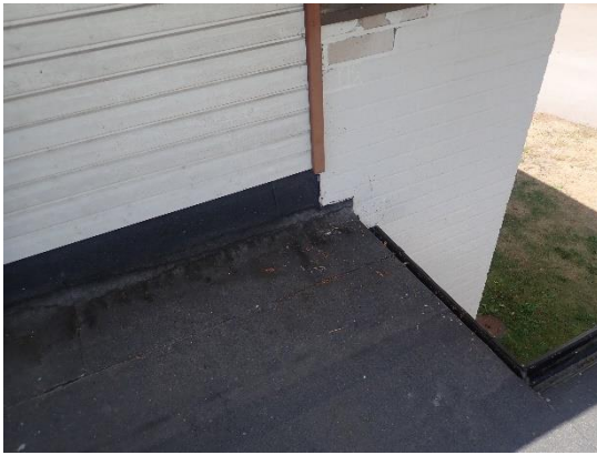
Kuva 74. Vesikatteen nosto seinälle loppuu ennen räystästä
