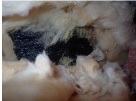
Kuva 16. Rakenneavaus lämmönjakohuoneen maanpaineseinästä
