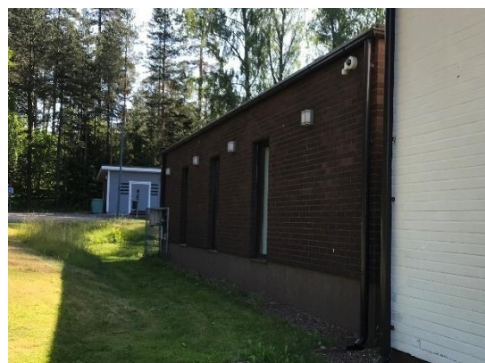
Kuva 89. Korkeampi sokkeli kuntosalin osalla
