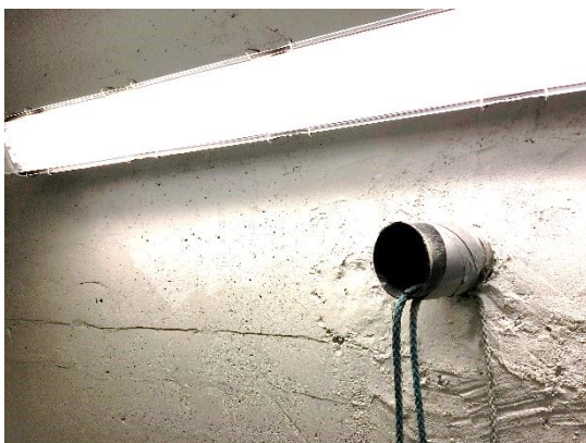
Kuva 13. Maanpaineseinän läpivienti
