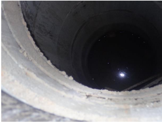
Kuva 7. Kuntosalin alapohjassa oleva vanha perusvesikaivo.
