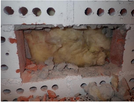
Kuva 15. Rakenneavaus lämmönjakohuoneen maanpaineseinästä
