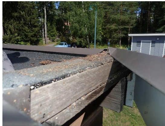
Kuva 71. Rakenneavaus räystäällä, kermi jatkuu riittävän pitkälle
