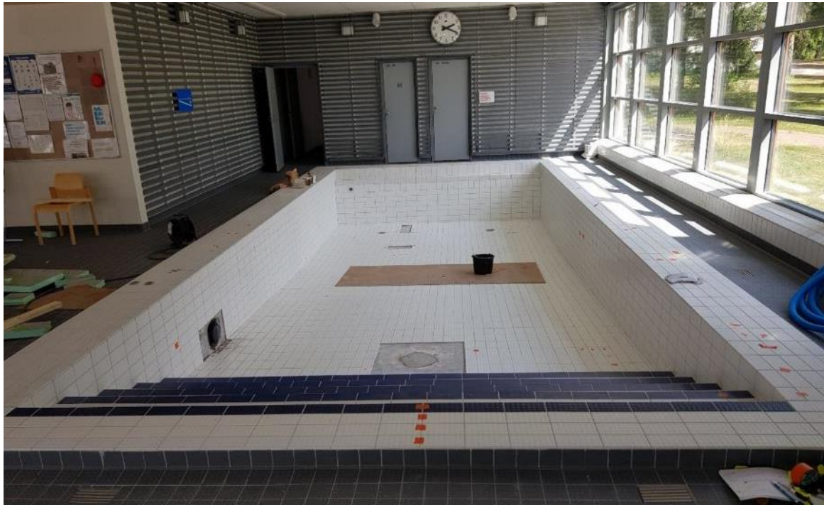
Kuva 24. Lastenallas. Käynti altaaseen on altaan päädyssä olevia betoniportaita pitkin.
