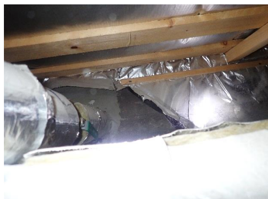
Kuva 57. Puristusliitos, ei täysin jatkuva
