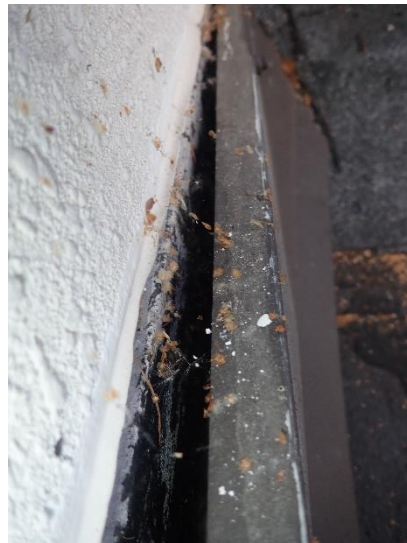
Kuva 73. Avoin liittymäpellityksen yläreunan liittymä
