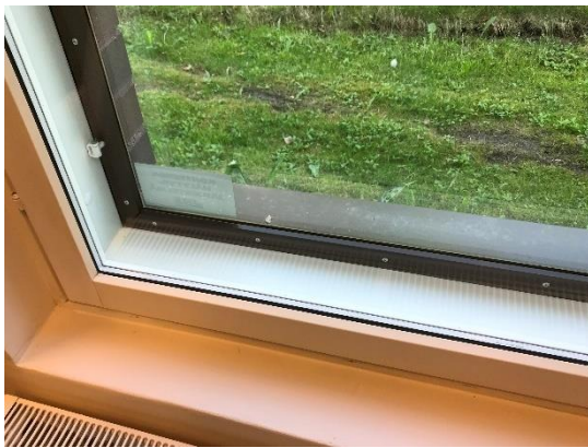
Kuva 32. Laajennuksen uusi ikkuna
