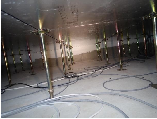
Kuva 45. Valvomon korokelattia
