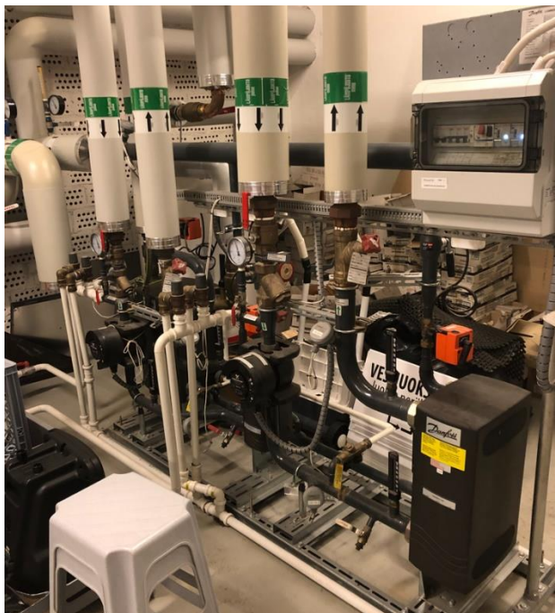
Kuva 92. Lämmönjakokeskus
