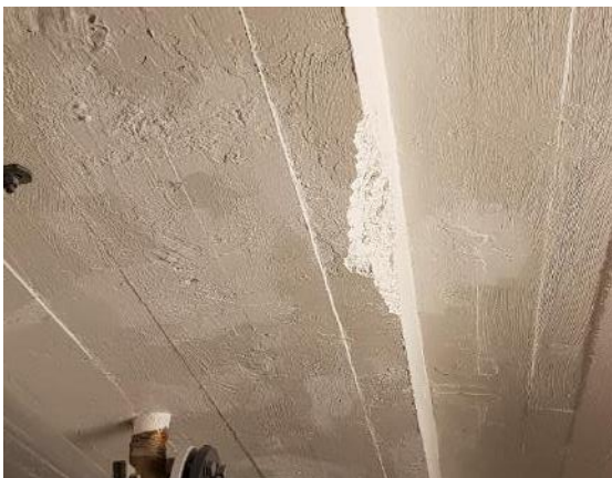
Kuva 17. Paikkauksia kellarikäytävän katossa, uima-altaan vieressä
