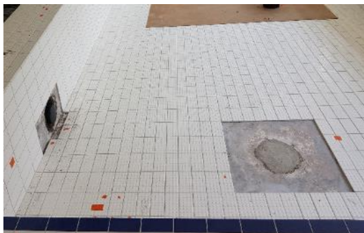
Kuva 3. Lastenaltaan korjauskohtia
