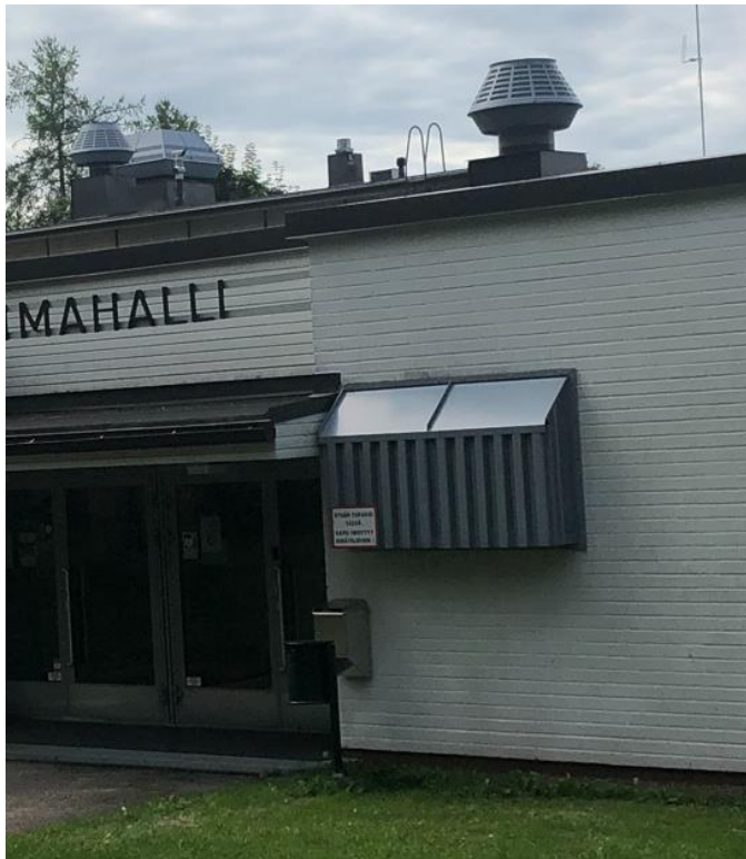
Kuva 96. Raitisilmanottolaite (Lumikilpi, Jeven Oy) sekä katolla jäteilman ulospuhalluslaitteet (Pyramid ja Ufojet, Jeven Oy)
