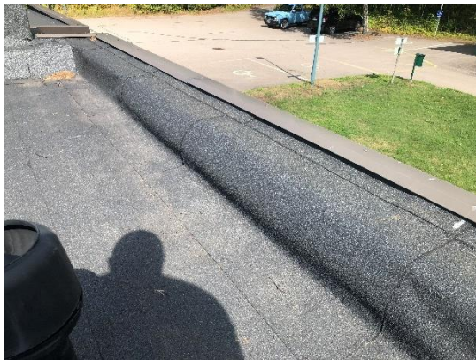
Kuva 76. Jyrkkä räystääskorotus
