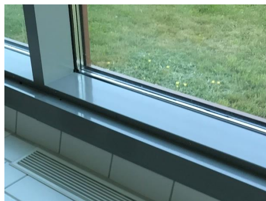
Kuva 33. Peruskorjauksessa uusittu lasiseinä
