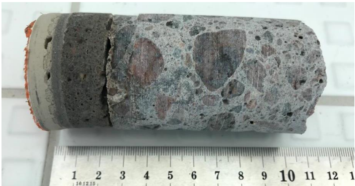
Kuva 30. Näyte AS5, lastenaltaan näytteiden betonissa havaittiin ilmarakkuloita ja eri rakennekerrosten tartunnat irtosivat toisistaan porauksissa
