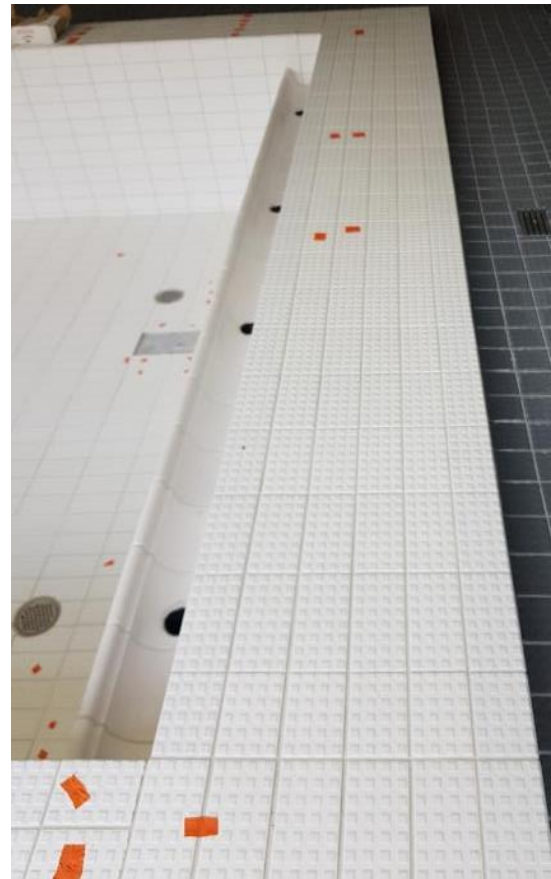
Kuva 27. Lastenaltaan loiskekouru on syvässä päädyssä
