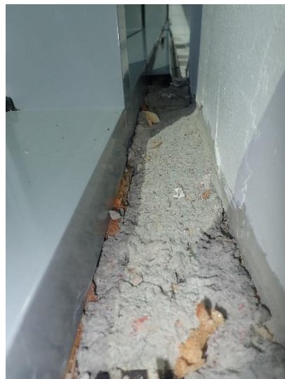
Kuva 35. Pilarin taustan liittymä, pellitys avattuna
