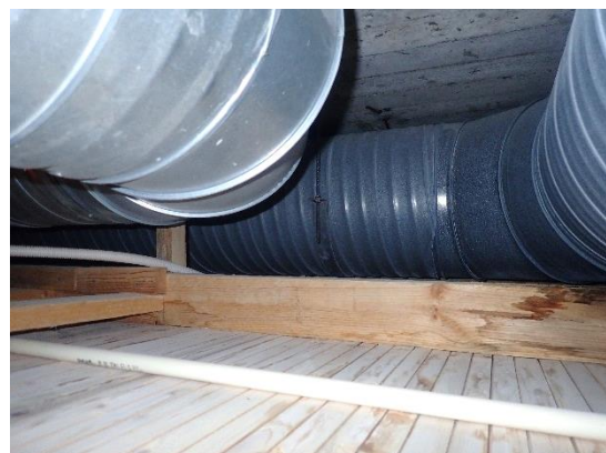
Kuva 59. Kondenssikosteusjälkiä alakattotilassa
