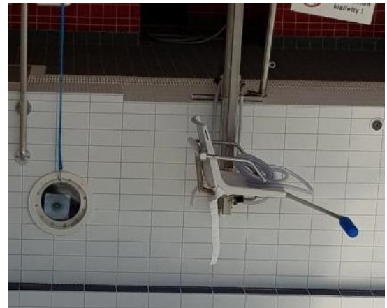
Kuva 10. Altaaseenlaskulaite ja altaan ikkuna
