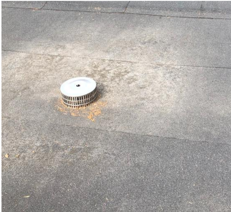
Kuva 94. Kattokaivo vesikatolla
