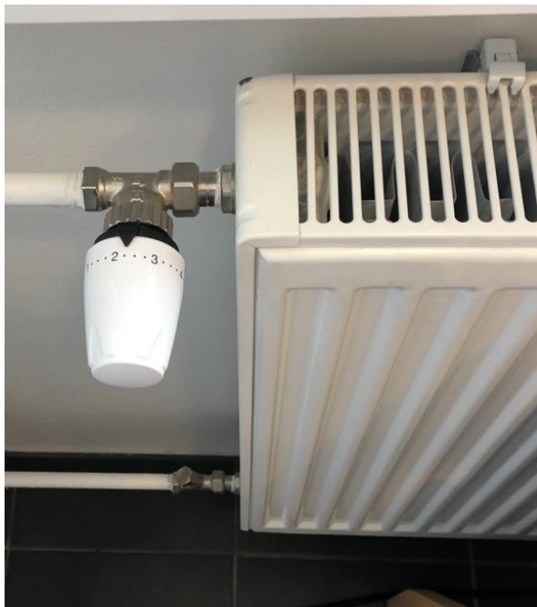
Kuva 93. Radiaattori aulatilassa
