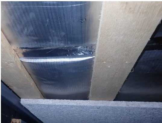
Kuva 56. Höyrynsulkujen liitos
