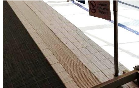
Kuva 12. Loiskekourut ovat altaan pitkällä sivuilla
