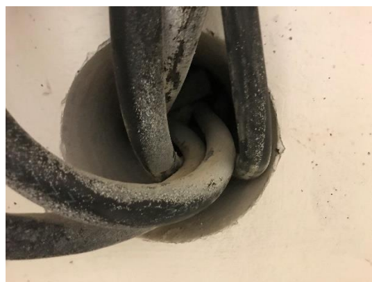
Kuva 14. Maanpaineseinän läpivienti
