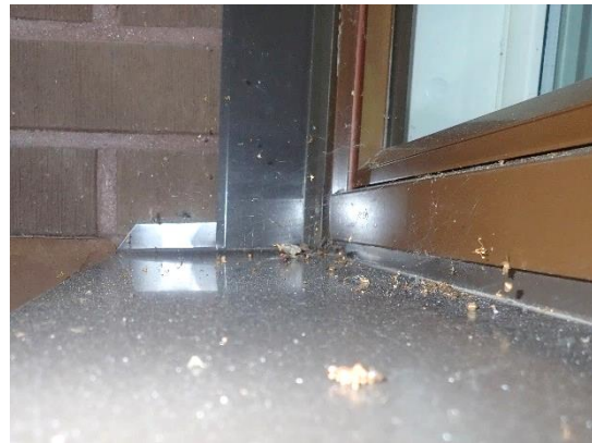
Kuva 37. Loivasti kalteva vesipelti kuntosalin osalla
