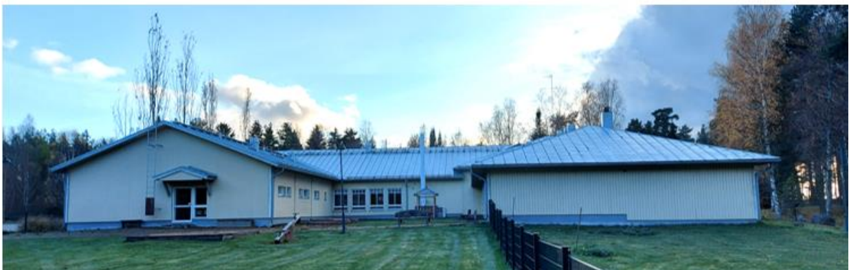
Kuva 17. Niinirannan toimintakeskuksen päärakennus.
