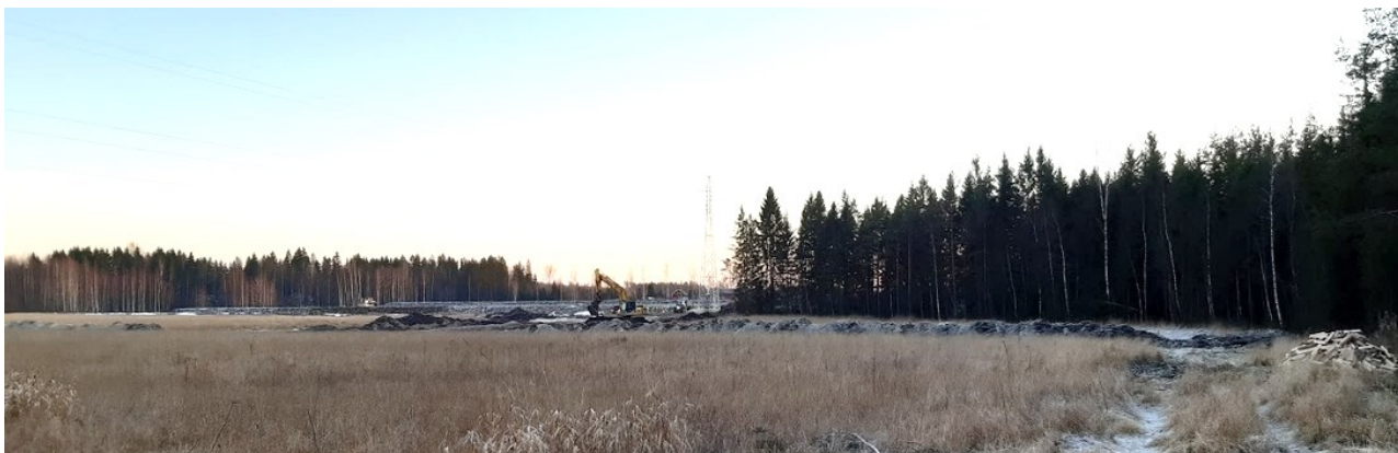
Kuva 5. Näkymä kaavasuunnittelualueen eteläreunalta kohti etelää. Taustalla käynnissä logistiikka-alueen käynnissä olevat rakentamistyöt.
