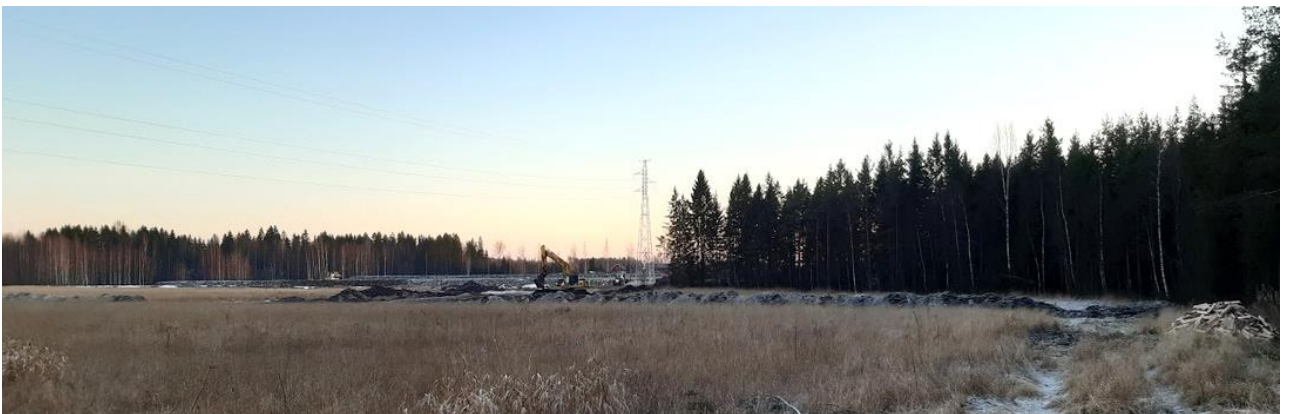
Kuva 5. Näkymä kaavasunnittelualueen eteläreunalta kohti etelää. Taustalla käynnissä logistiikka-alueen käynnissä olevat rakentamistyöt.
