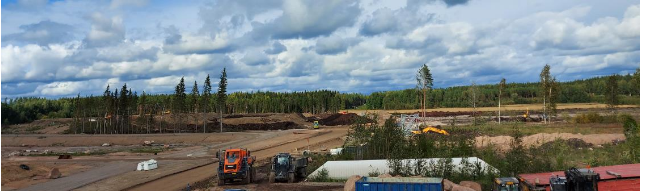
Kuva 2. Näkymä rakenteilla olevan intermodaalialueen pohjoisosasta kohti pohjoista. Kullasvaara 3 asemakaavan suunnittelualuetta ovat rakennustyömaan takana näkyvät pellot ja metsät.
