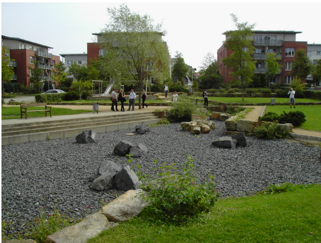
Kuva 7. Esimerkki kasvipeitteettömästä suodatusrakenteesta.
