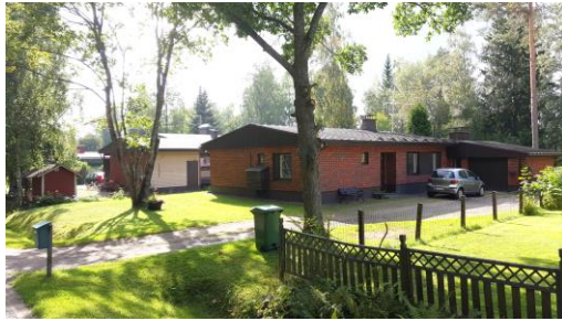
Kuva 3. Matalaa rakentamista Riihitiellä.
