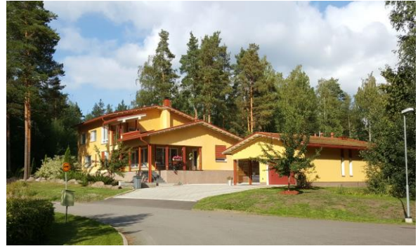
Kuva 15. 2000-luvun rakentamista alueen pohjoisosassa.
