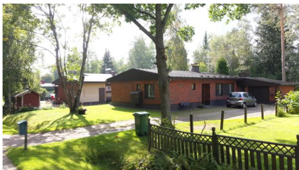
Kuva 8. Matalaa rakentamista Riihitiellä.
